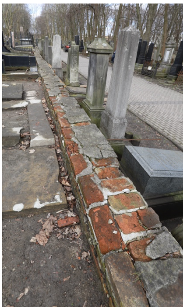
Foto. 6. Kwatera 24, wschodnie i zachodnie zwieńczenie murów. Część wschodnia pokryta wyprawą założoną na cegły ułożone zgodnie z biegiem murowania. Część zachodnia z widocznym ułożeniem cegieł w sposób „dekoracyjny” na dłuższych bokach z widoczną, szczególnie zachowaną zaprawą cementową.
