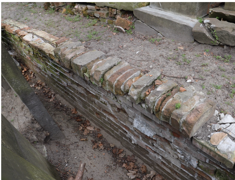
Foto. 6. Kwatera 24, wschodnie i zachodnie zwieńczenie murów. Część wschodnia pokryta wyprawą założoną na cegły ułożone zgodnie z biegiem murowania. Część zachodnia z widocznym ułożeniem cegieł w sposób „dekoracyjny” na dłuższych bokach z widoczną, szczególnie zachowaną zaprawą cementową.
