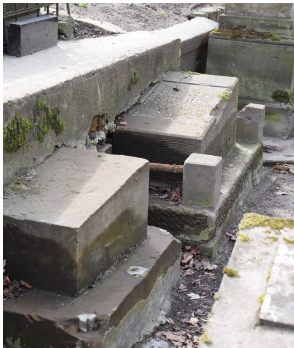
Foto. 5. Kwatera nr 31, mur wschodni i północny z widocznym odpajającym się tynkiem cementowym, zakończonym na przypadkowej wysokości powyżej dolnych partii nagrobków oraz „oblewającym” górne płaszczyzny niższych nagrobków.
