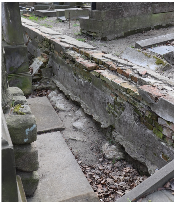
Foto. 5. Kwatera nr 31, mur wschodni i północny z widocznym odpajającym się tynkiem cementowym, zakończonym na przypadkowej wysokości powyżej dolnych partii nagrobków oraz „oblewającym” górne płaszczyzny niższych nagrobków.
