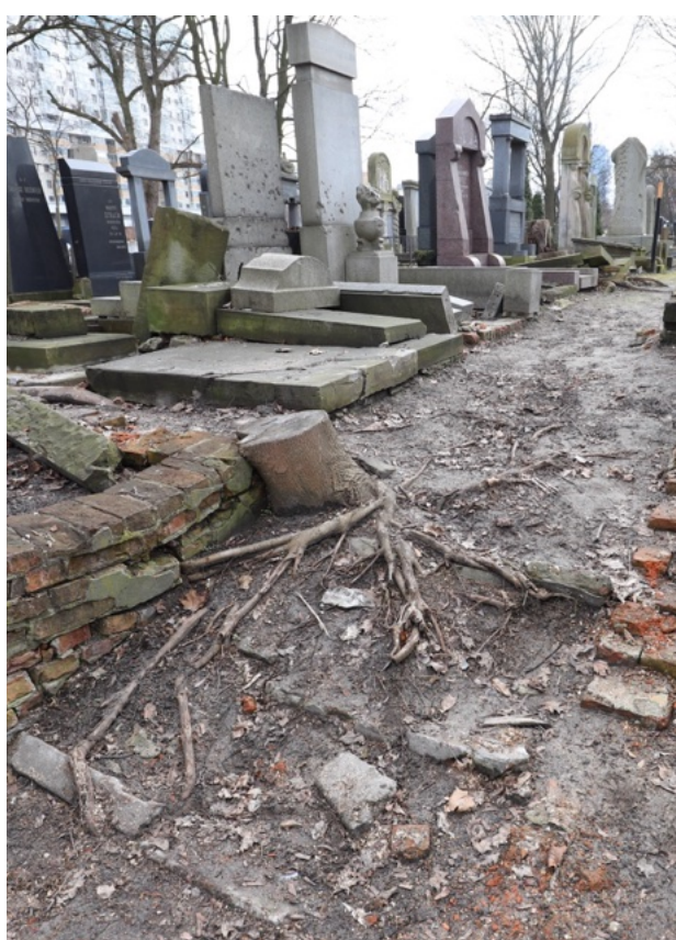
Foto. 35-37. Kwatera 19, schody terenowe ściany północnej przerośnięte przez korzeń, wykonane z fragmentów macew i elementów betonowych.
