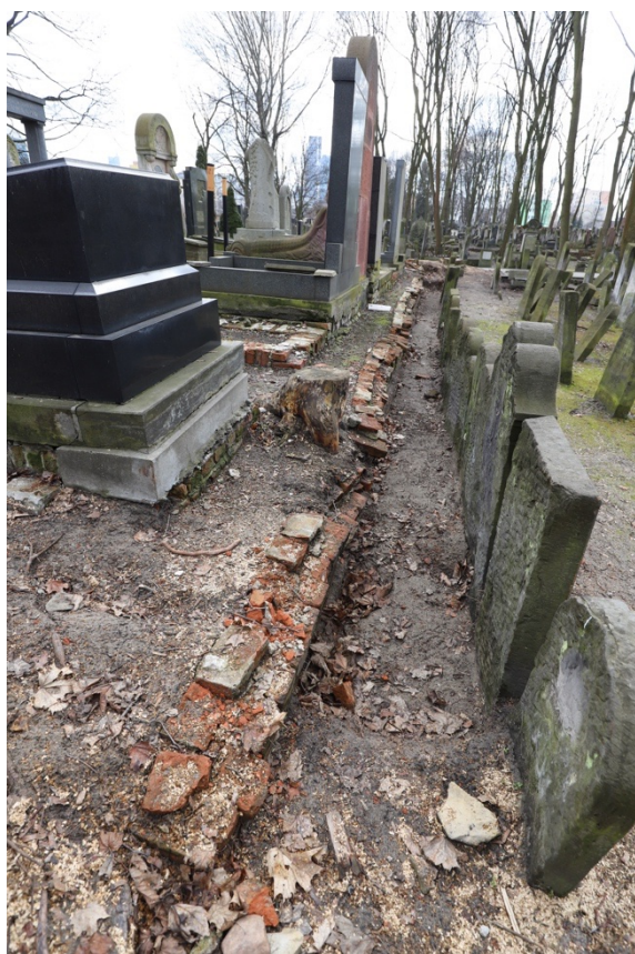
Foto. 18-21. Kwatera 19, widok ogólny muru zachodniego z rozwarstwowaną, zdestruowaną koroną
