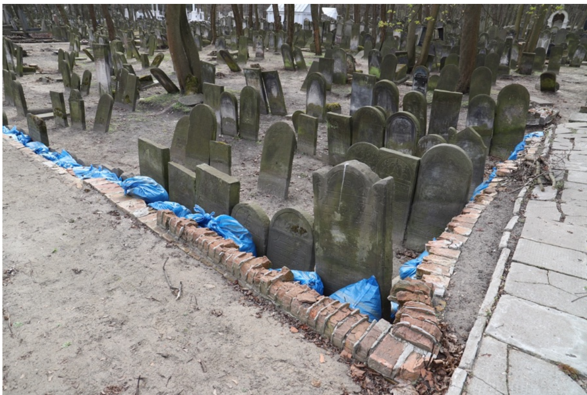
Foto. 170. Kwarta 31. Widok ogólny odkształconych fragmentu ściany zachodniej i południowo-zachodniego narożnika prowizorycznie zabezpieczonych przed powaleniem.
