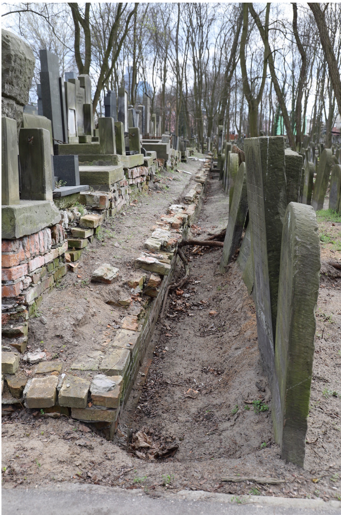
Foto. 74. Kwatera 24. Widok ogólny muru zachodniego od strony północnej.
