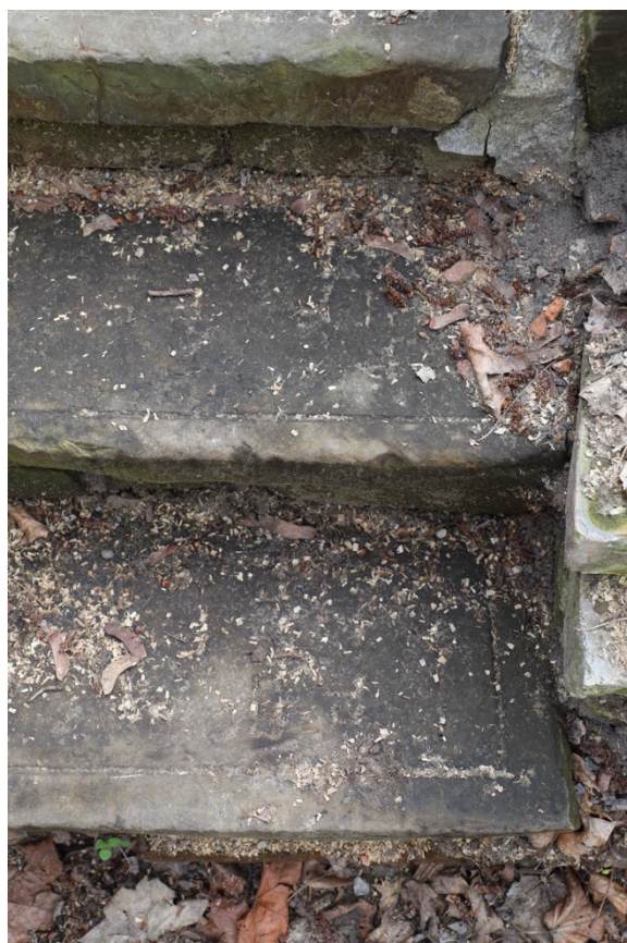
Foto. 93-95. Kwatera 24. Schody terenowe ściany północnej wykonane z macew ułożonych na ceglach.
