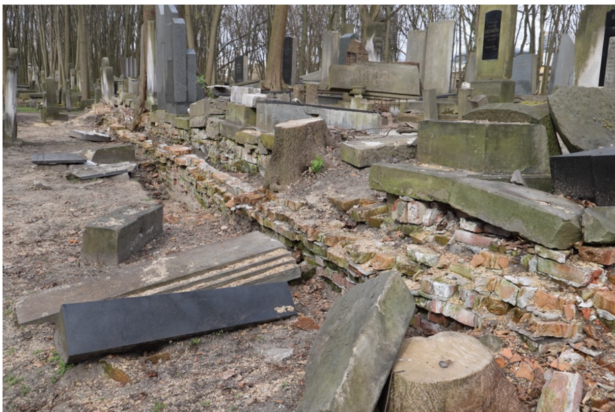
Foto. 176-177. Kwatera 31. Widok ogólny fragmentu ściany zachodniej z powalonymi nastawami nagrobków ustawionych na nasypie.
