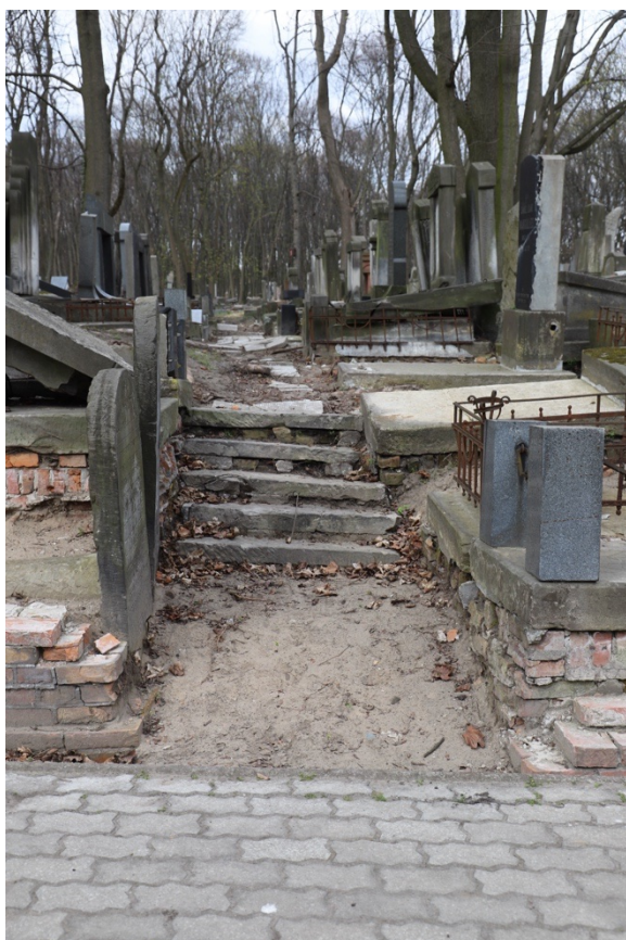
Foto. 114-116. Kwatera 24. Schody terenowe ściany południowej wykonane z macew ułożonych na ceglach
