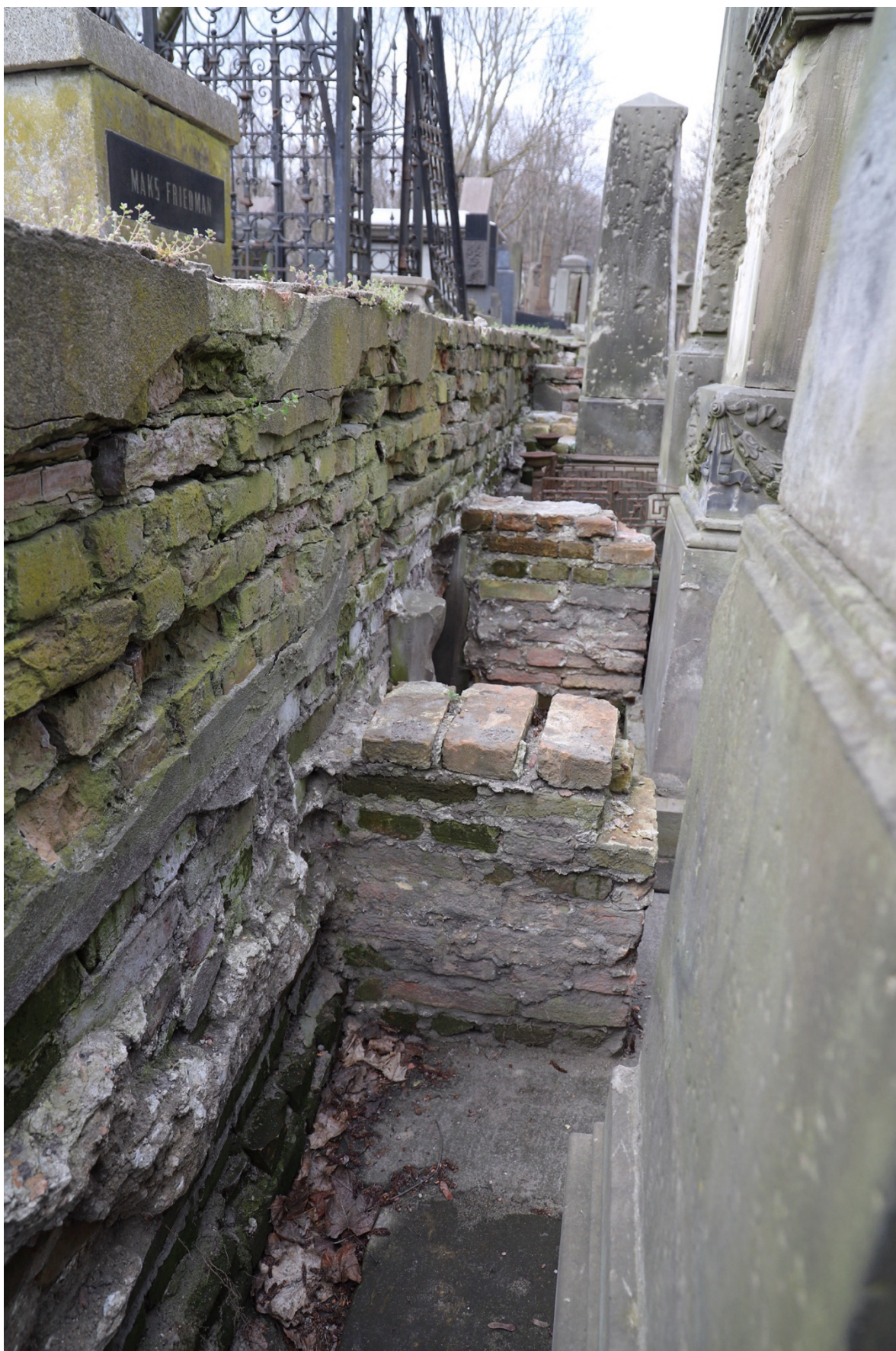
Foto. 46. Kwatera 24. Front muru wschodniego. Widoczne wtórnie dobudowane przypory ustawione na płytach podstaw nagrobków oraz szczątkowo zachowane cementowe tynki, których granice sięgają połowy wysokości.
