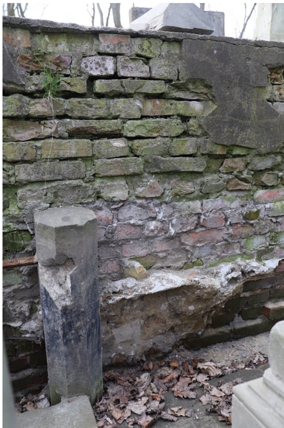
Foto. 47-50. Kwatera 24. Front muru wschodniego. Widoczne obudowywanie części składowych nagrobków oraz szczerzątkowo zachowane cementowe tynki, których spodnie krawędzie sięgają różnych wysokości.
