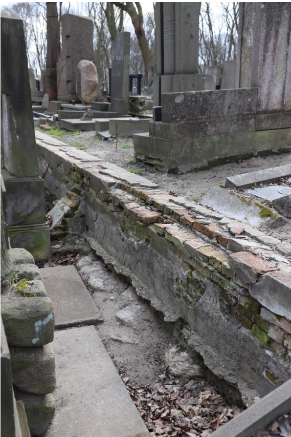
Foto. 132-135. Kwatera 31. Front muru wschodniego. Widoczne obudowywanie części składowych nagrobków oraz szczerunkowo zachowane cementowe zwieńczenie i tynki, których spodnie krawędzie sięgają różnych wysokości muru.
