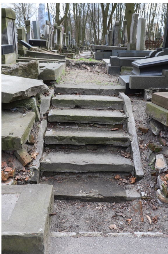
Foto. 105-107. Kwatera 24. Schody terenowe ściany północnej wykonane z macew ułożonych na cegłach.
