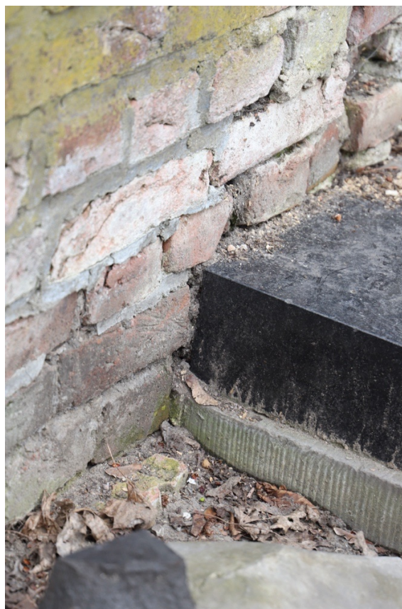
Foto. 151-154. Kwatera 31. Stan zachowania fragmentu ściany południowej nabudowanej na elementach nagrobków.
