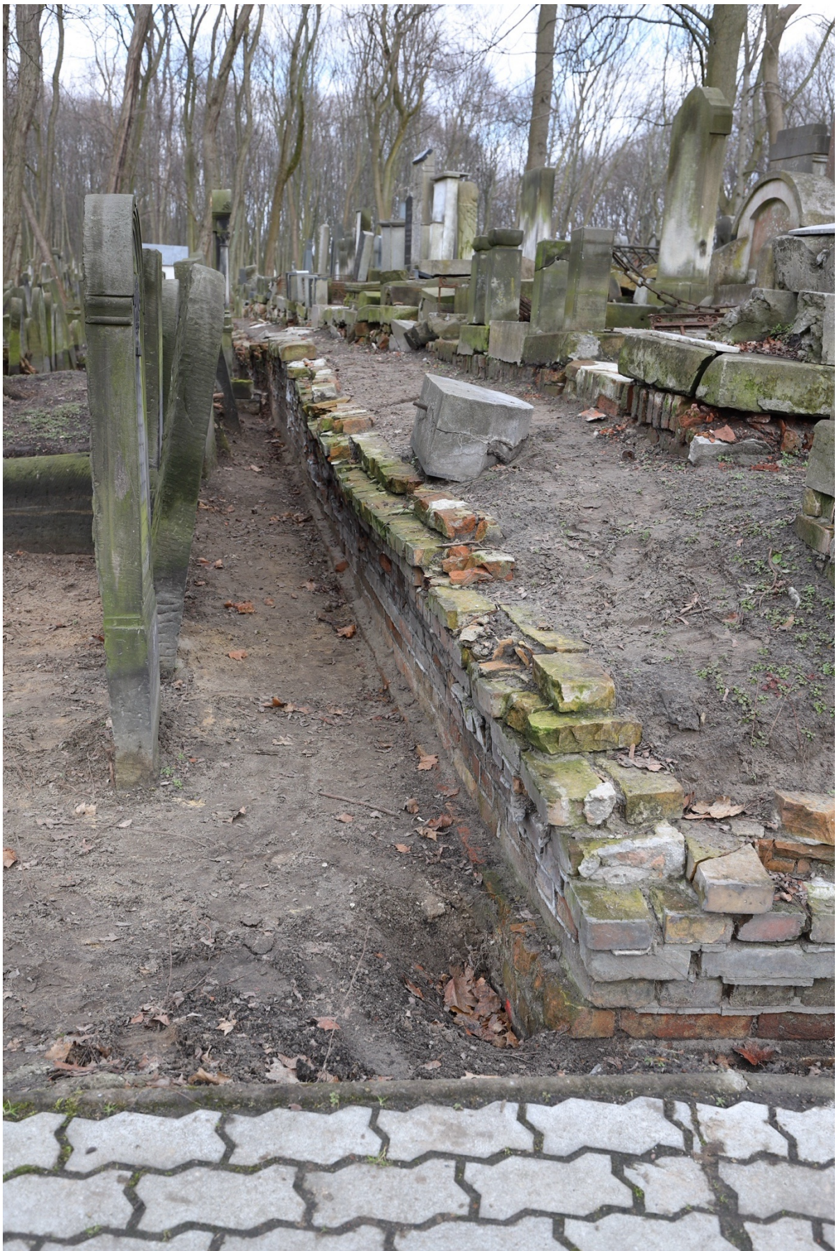
Foto. 73. Kwata 24. Widok ogólny muru zachodniego od strony południowej.
