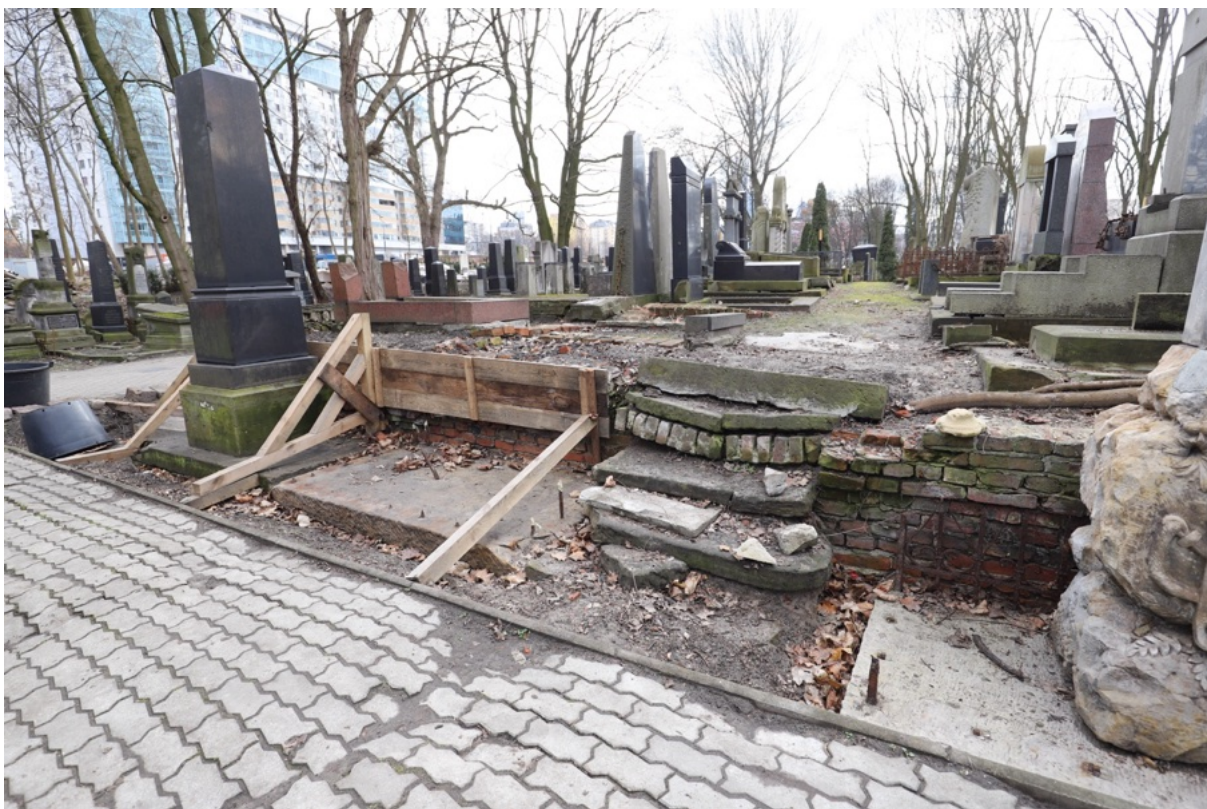
Foto. 23. Kwata 19, widok ogólny fragmentu muru północnego.
