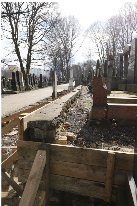
Foto. 6-10. Kwatera 19. Mur wschodni. Widoczne nabudowanie konstrukcji na elementach podstaw nagrobków.
