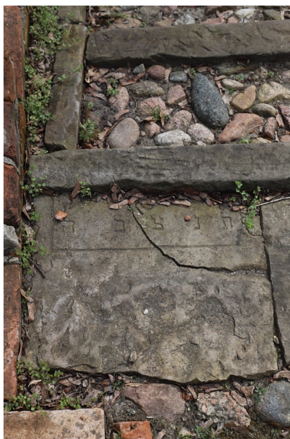
Foto. 29-31. Kwatera 19, schody terenowe ściany południowej wykonane z otoczaków ograniczonych fragmentami macew.
