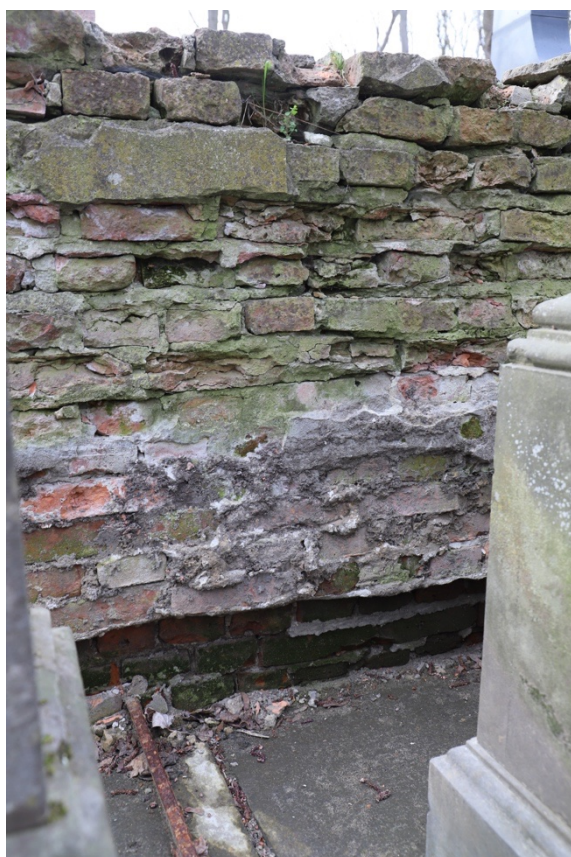
Foto. 56-59. Kwatera 24. Front muru wschodniego. Widoczne obudowywanie części składowych nagrobków oraz szczerunkowo zachowane cementowe tynki, których spodnie krawędzie sięgają różnych wysokości
