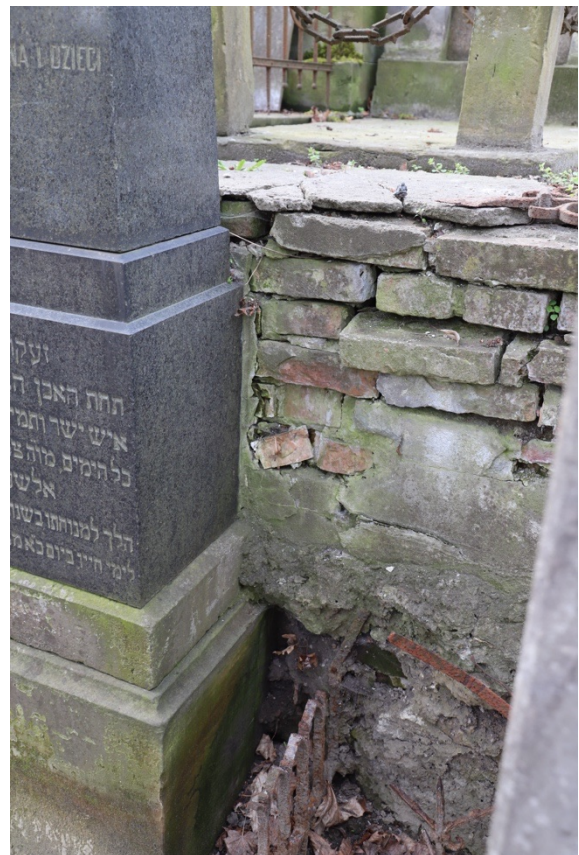
Foto. 136-139. Kwatera 31. Front muru wschodniego. Widoczne obudowywanie części składowych nagrobków oraz przebudowany fragment stopni prowadzących do nagrobka ustawionego na nasypie.
