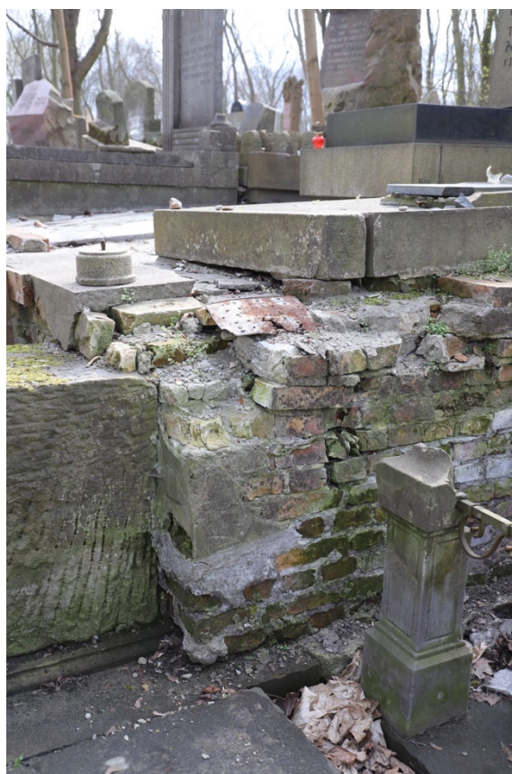
Foto. 128-131. Kwatera 31. Front muru wschodniego z rozwarstwieniami cementowego zwieńczenia oraz fragmentami nabudowanymi na elementach nagrobka oraz niewłaściwe przewiązanie cegieł narożnika.
