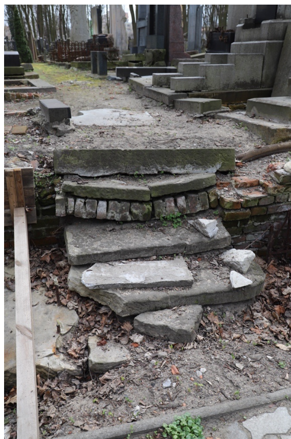
Foto. 32-34. Kwata 19, schody terenowe ściany północnej, wykonane z fragmentów macew jako stopnic i fragmentów cegieł tworzących podstopnice.
