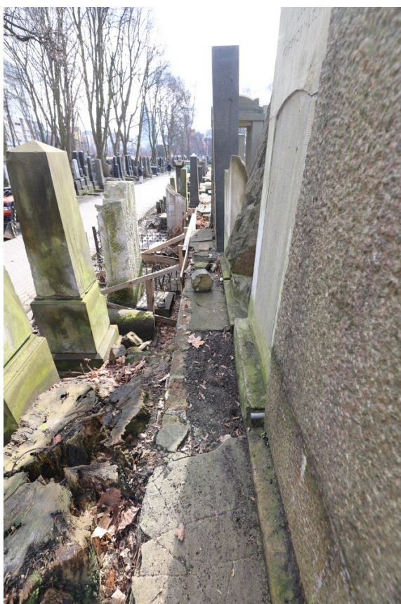
Foto. 128-131. Kwatera 31. Front muru wschodniego z rozwarstwieniami cementowego zwieńczenia oraz fragmentami nabudowanymi na elementach nagrobka oraz niewłaściwe przewiązanie cegieł narożnika.
