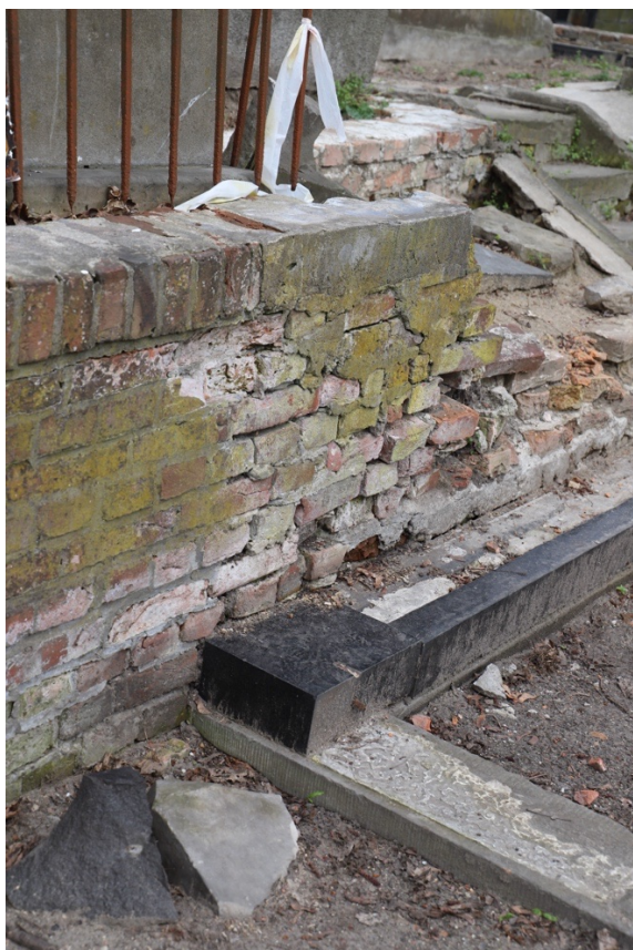
Foto. 151-154. Kwatera 31. Stan zachowania fragmentu ściany południowej nabudowanej na elementach nagrobków.
