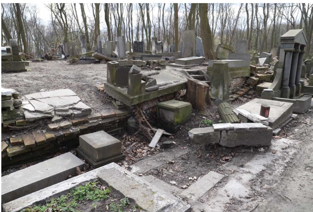
Foto. 191-192. Kwatera 31. Widok ogólny fragmentu muru ściany północnej.
