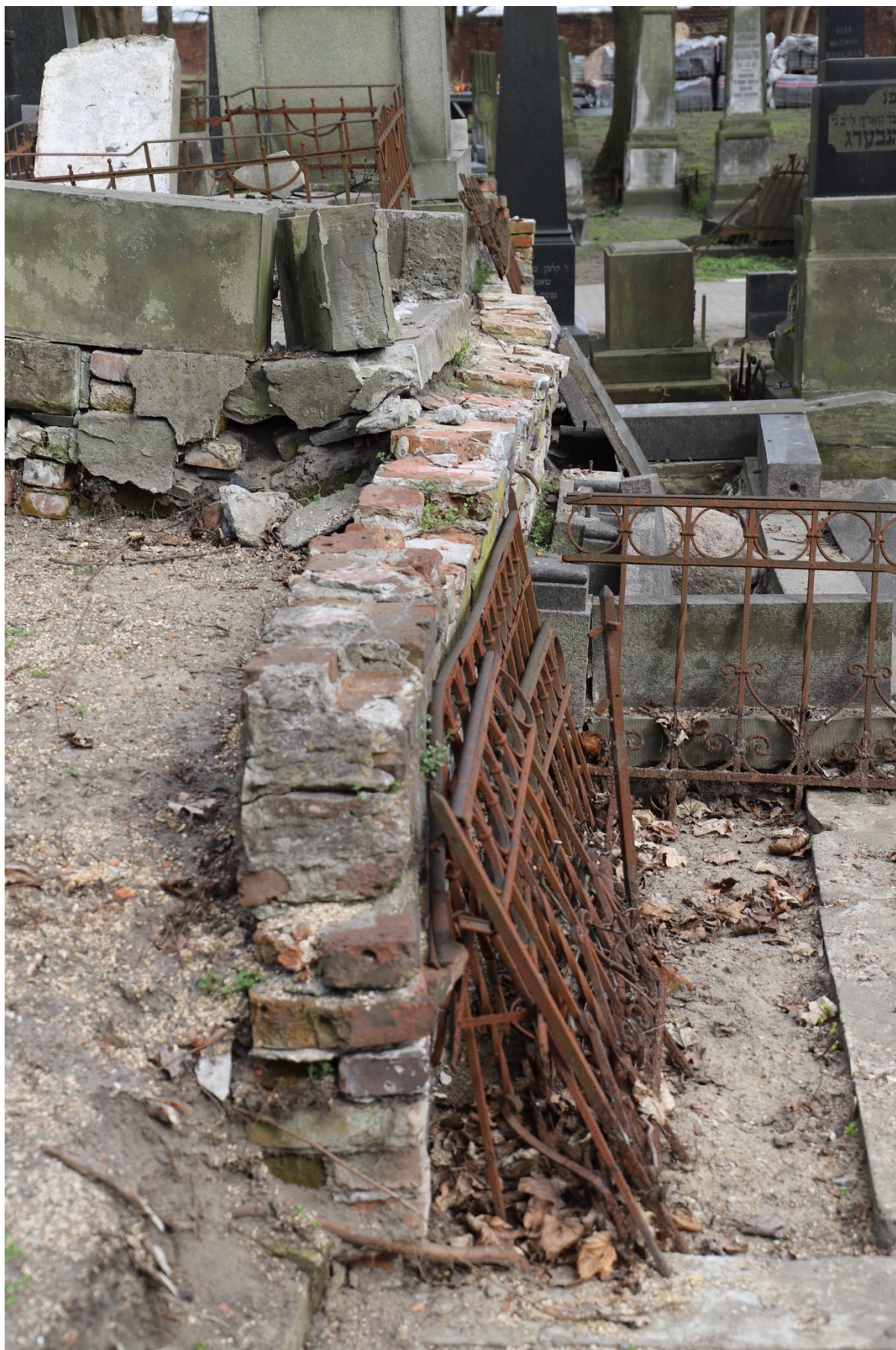
Foto. 68.. Kwatera 24. Odsztatcenie południowowo-wschodniego narożnika muru południowego.
