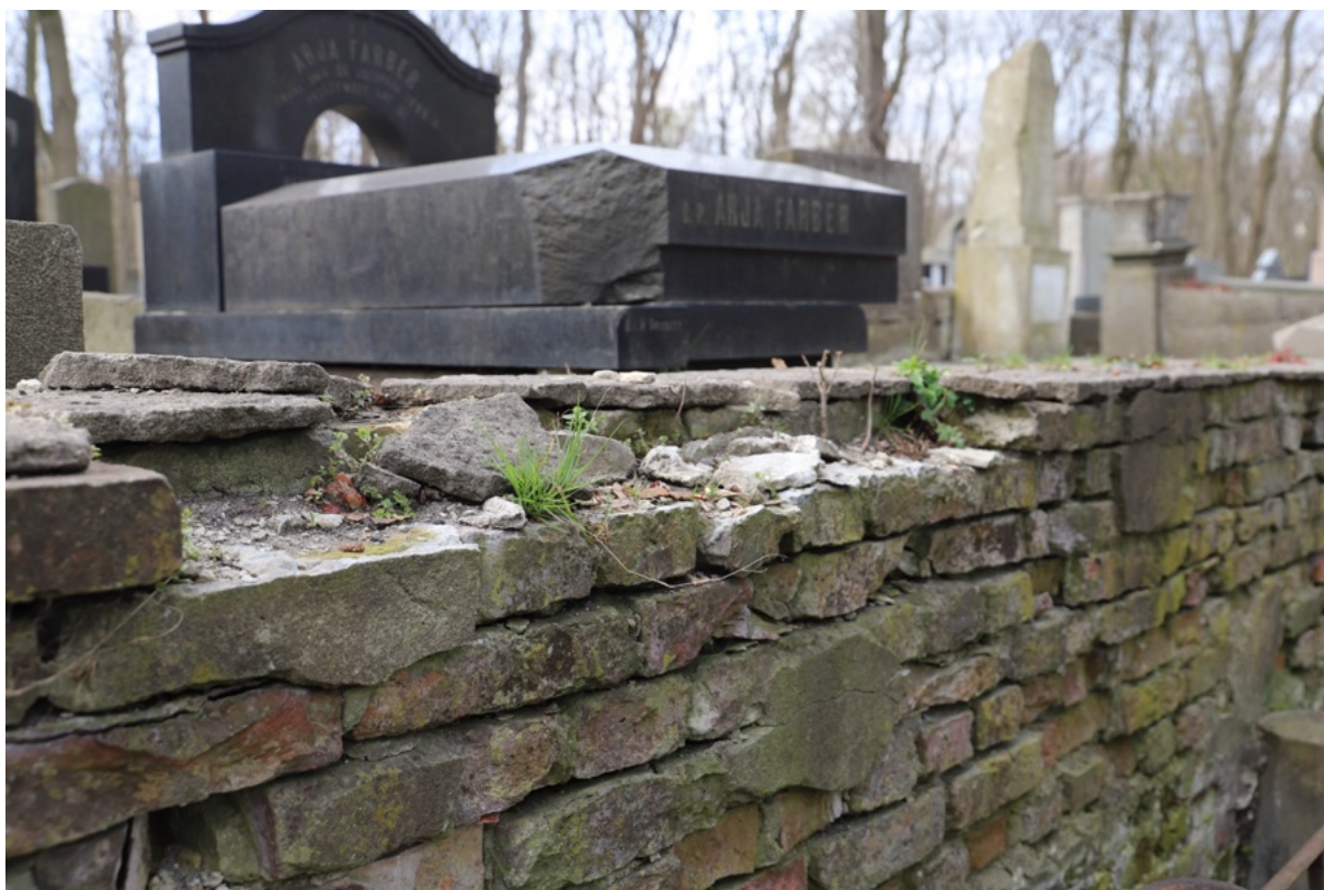
Foto. 43-44. Kwatera 24. Rozwarstwienia cementowego zwieńczenie muru wschodniego.
