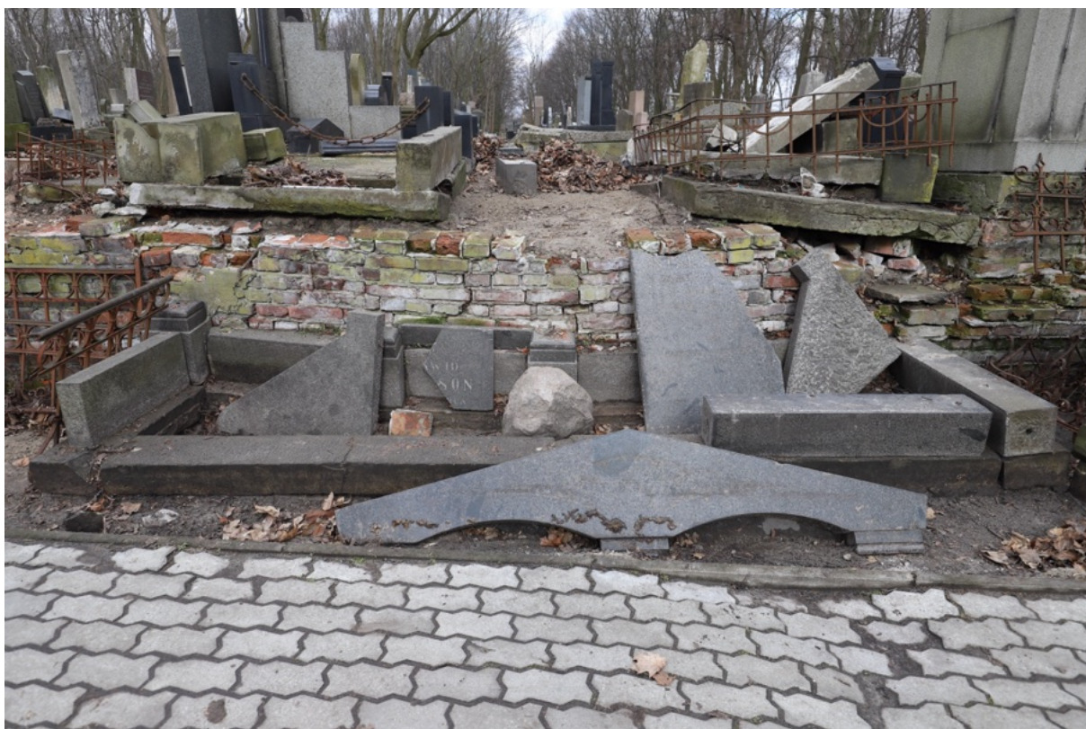
Foto. 120-121. Kwatera 24. Ściana południowa. Zamurowane i zasypane miejsca prawdopodobnego usytuowania schodów.
