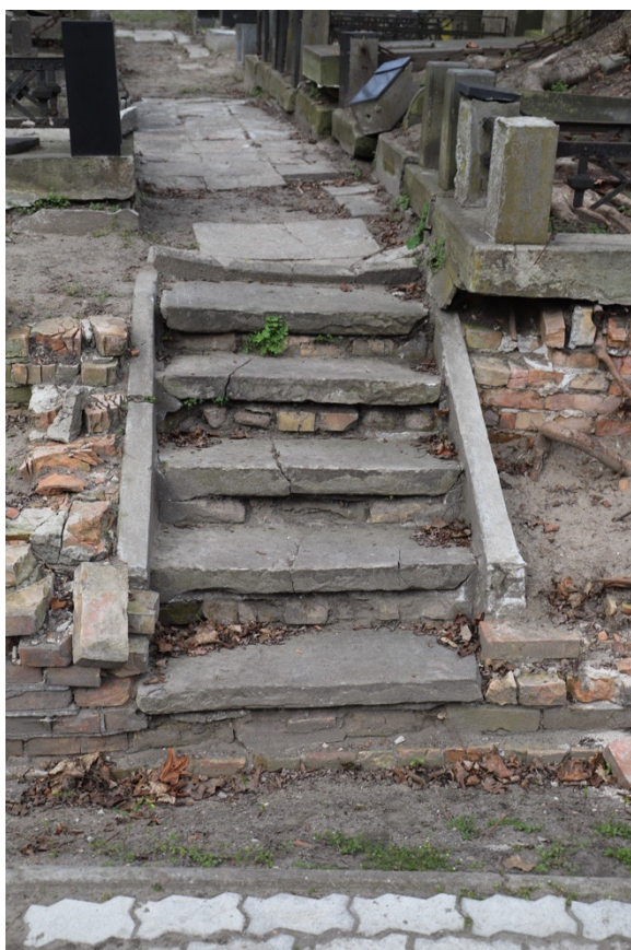
Foto. 111-113. Kwatera 24. Schody terenowe ściany południowej wykonane z macew ułożonych na cegłach.
