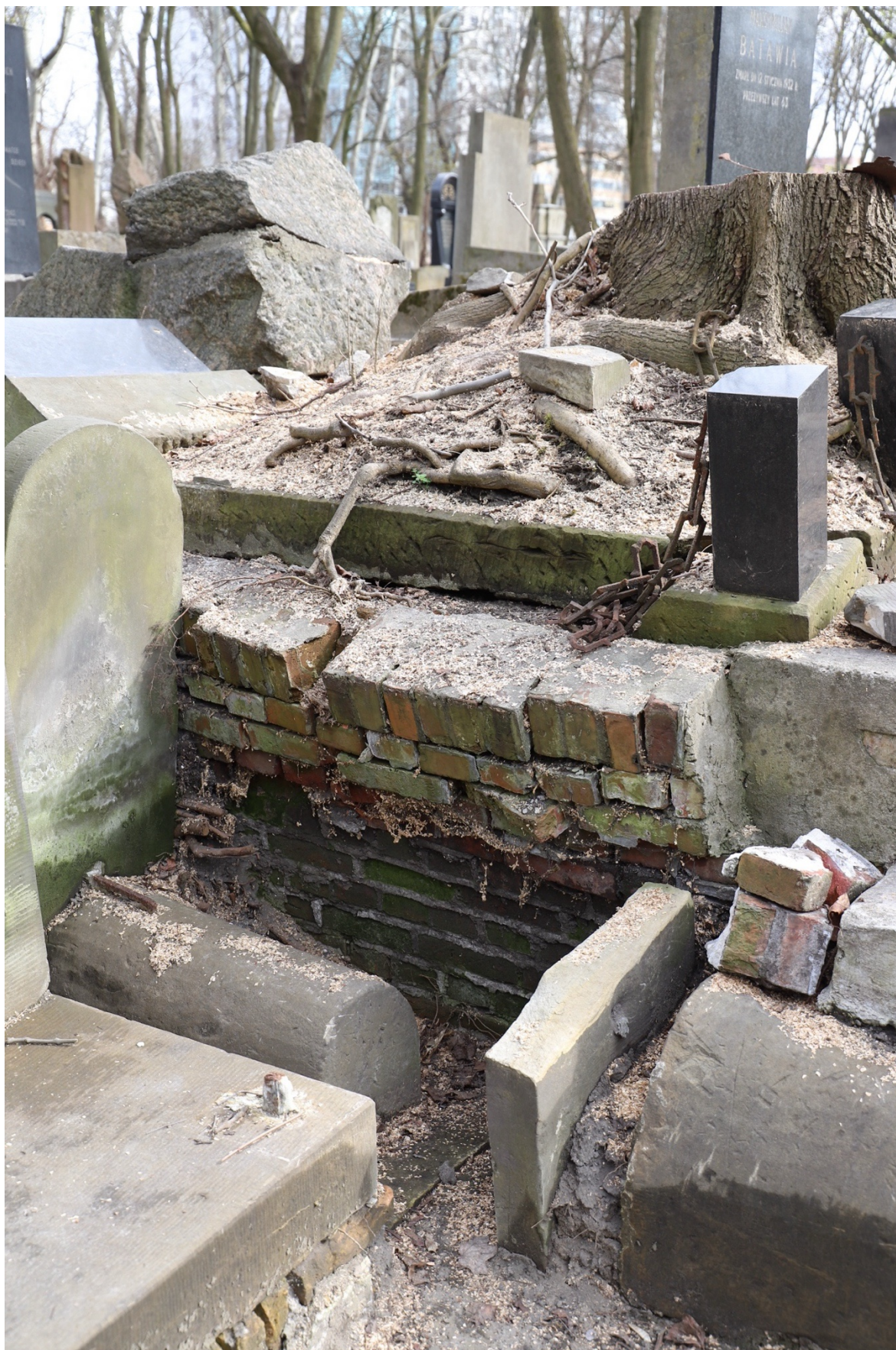
Foto. 199. Kwatera 31. Stan zachowania fragmentów muru ściany północnej.
