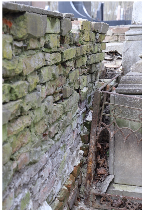
Foto. 47-50. Kwatera 24. Front muru wschodniego. Widoczne obudowywanie części składowych nagrobków oraz szczerzątkowo zachowane cementowe tynki, których spodnie krawędzie sięgają różnych wysokości.
