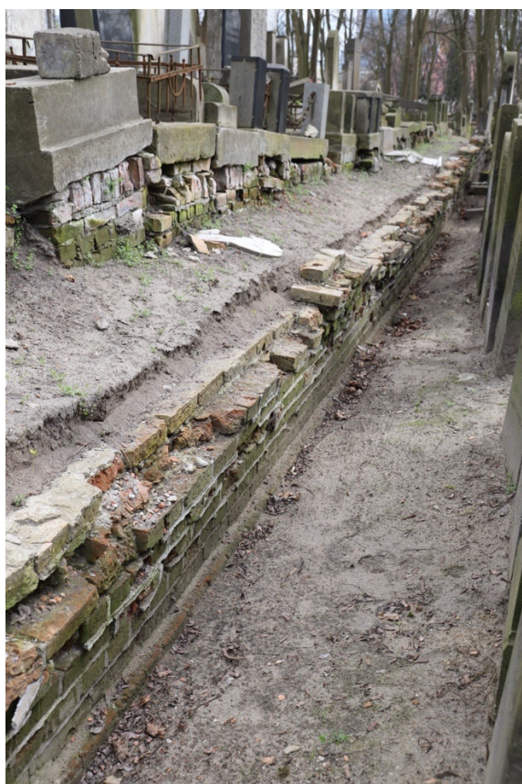
Foto. 75-78. Kwatera 24. Widok ogólny muru zachodniego z widocznymi odchyleniami od pionu i silnie zdestruowanymi cegłami.
