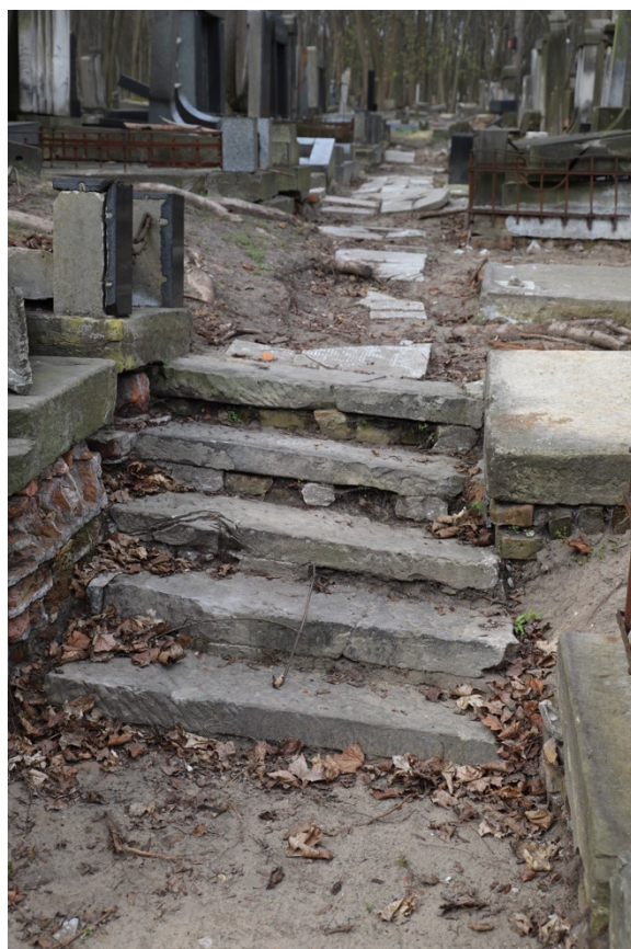
Foto. 114-116. Kwatera 24. Schody terenowe ściany południowej wykonane z macew ułożonych na ceglach
