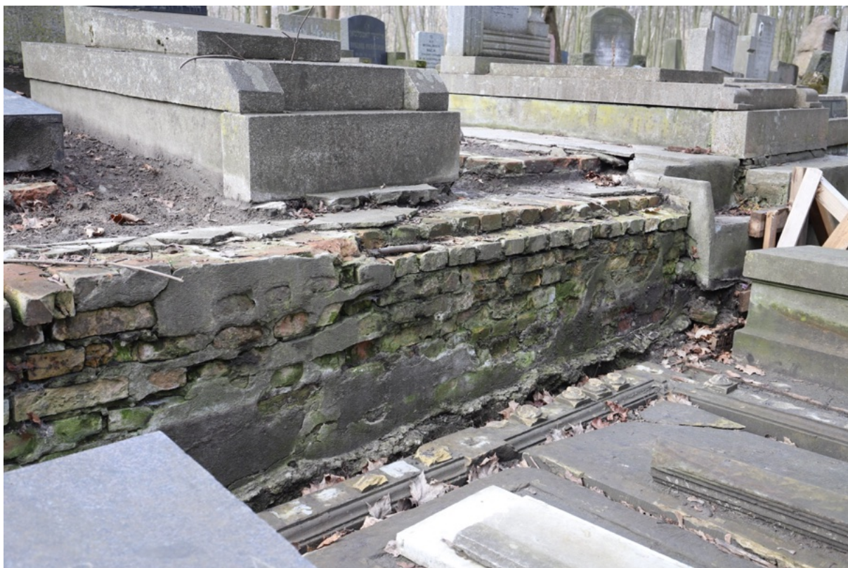
Foto. 126-127. Kwatera 31. Front muru wschodniego. Widoczne obudowywanie części składowych nagrobków oraz szczerunkowo zachowane cementowe tynki, których spodnie krawędzie sięgają różnych wysokości lica muru.
