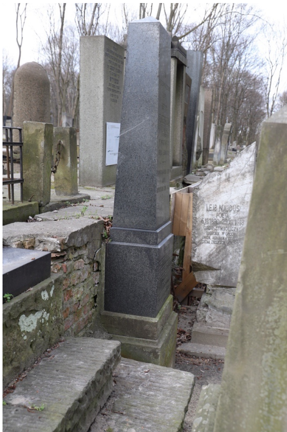
Foto. 136-139. Kwatera 31. Front muru wschodniego. Widoczne obudowywanie części składowych nagrobków oraz przebudowany fragment stopni prowadzących do nagrobka ustawionego na nasypie.
