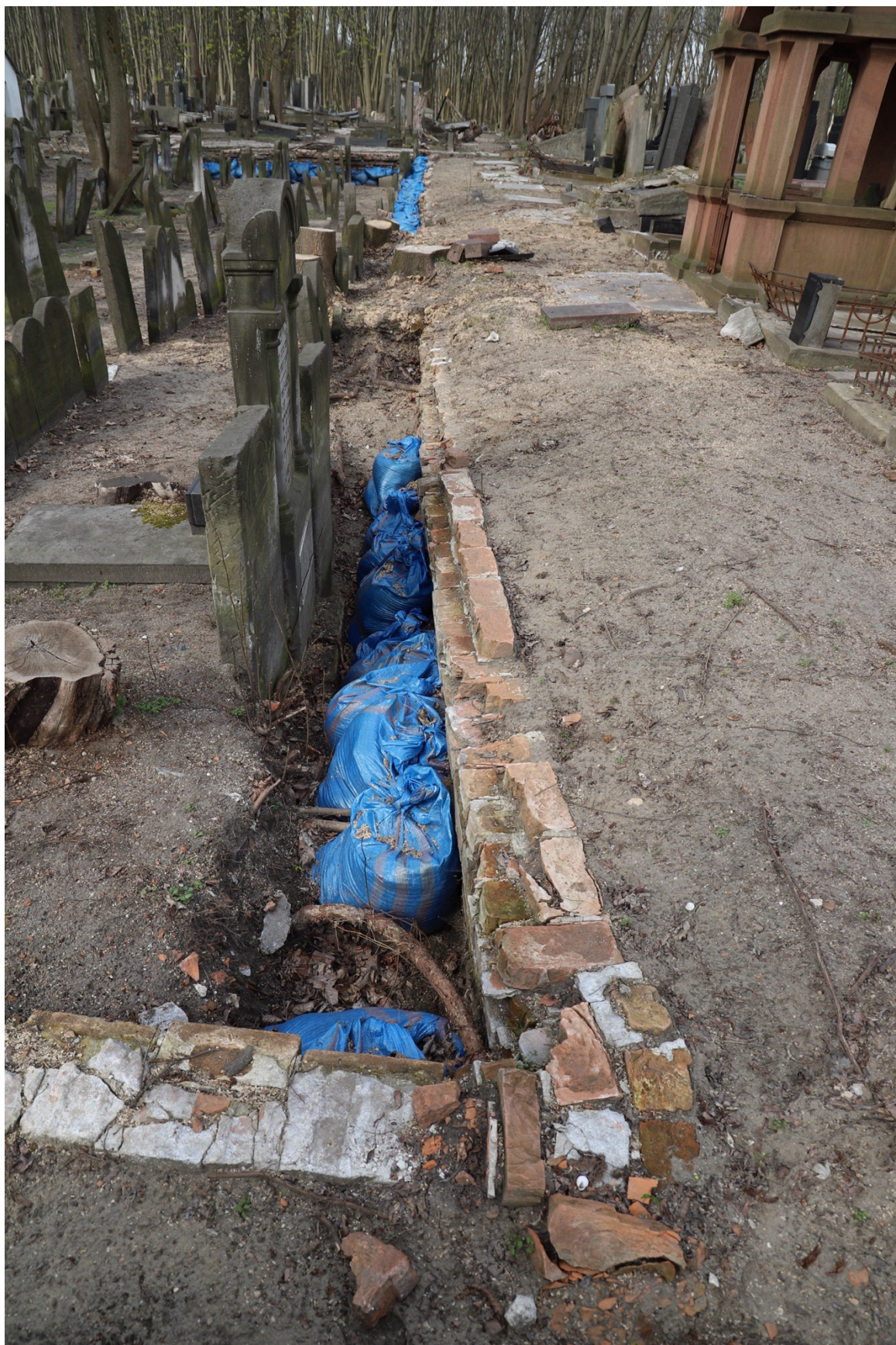
Foto. 166. Kwata 31. Widok ogólny fragmentu ściany zachodniej.
