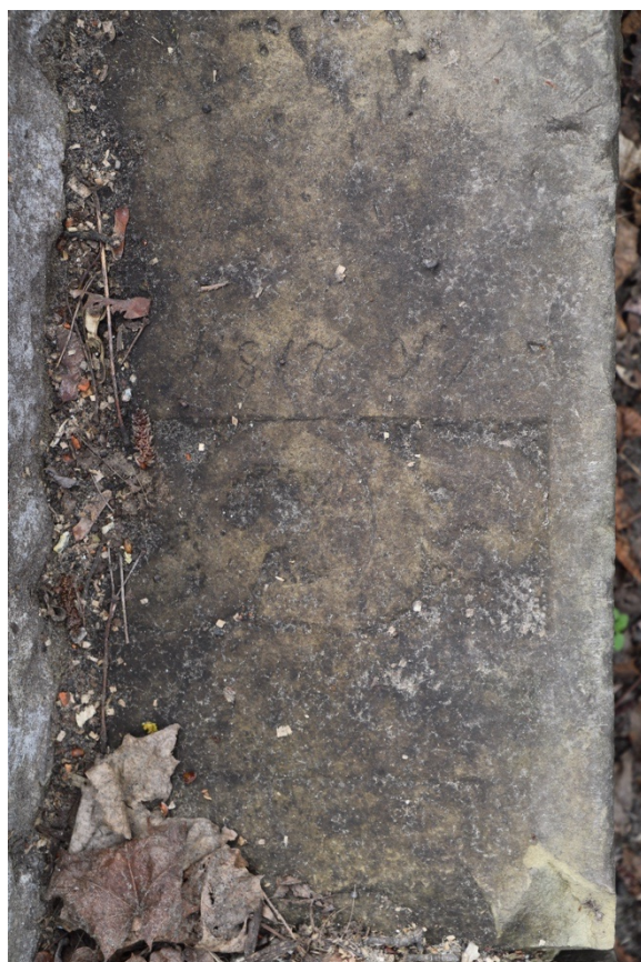
Foto. 102-104. Kwatera 24. Schody terenowe ściany północnej wykonane z macew ułożonych na cegłach uszczelnione w podstopnicach zaprawą cementową.
