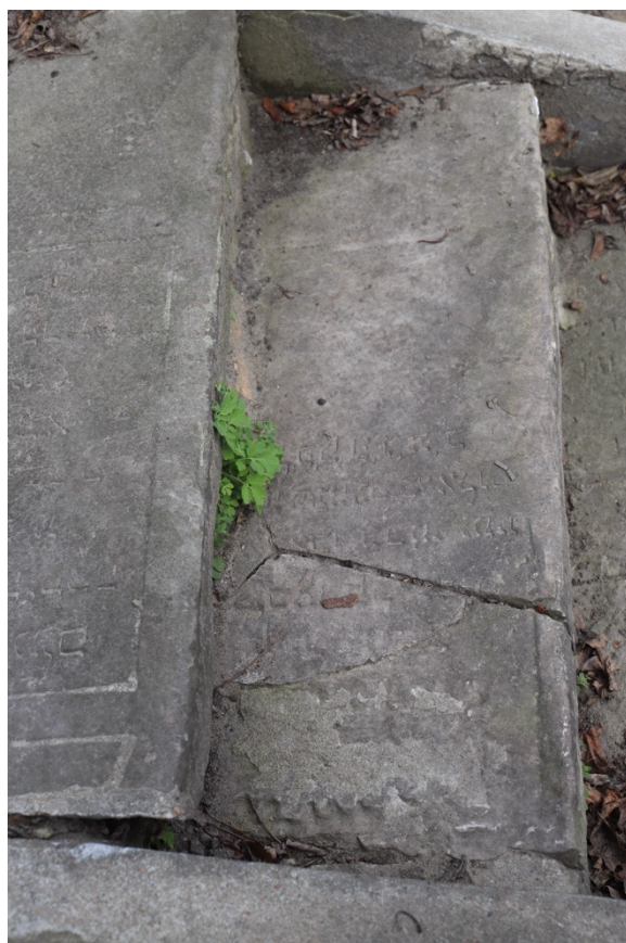
Foto. 111-113. Kwatera 24. Schody terenowe ściany południowej wykonane z macew ułożonych na cegłach.
