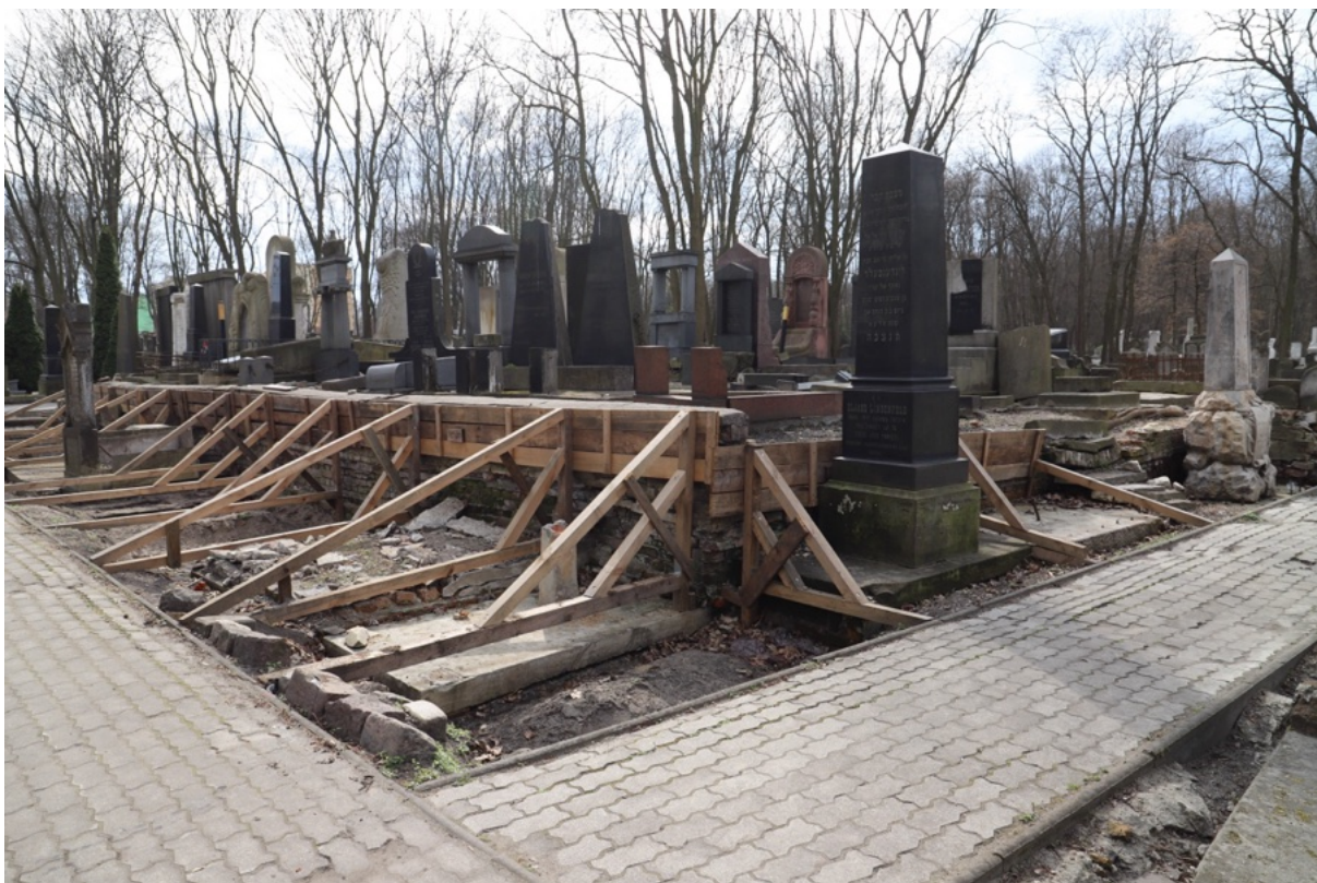
Foto. 22. Kwata 19, widok ogólny muru północno- wschodniego
