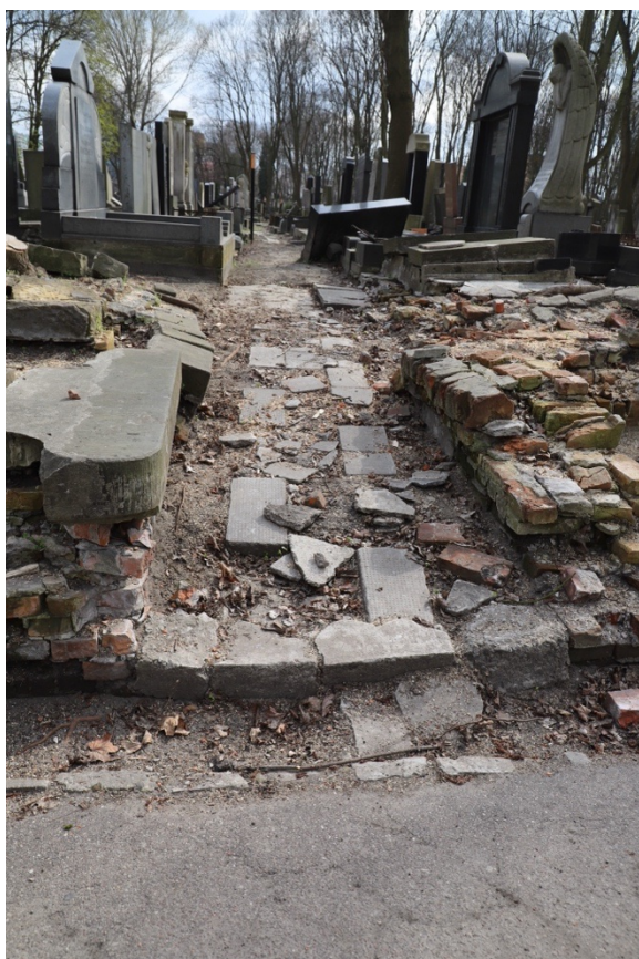
Foto. 96-98. Kwatera 24. Schody/podejście terenowe ściany północnej wykonane z płyt chodnikowych.
