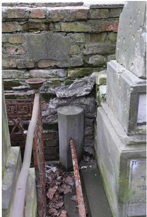
Foto. 51-54. Kwatera 24. Front muru wschodniego. Widoczne obudowywanie części składowych nagrobków oraz szczerzątkowo zachowane cementowe tynki, których spodnie krawędzie sięgają różnych wysokości.
