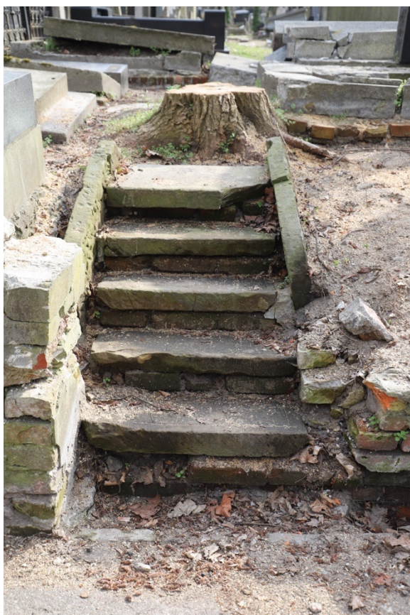
Foto. 93-95. Kwatera 24. Schody terenowe ściany północnej wykonane z macew ułożonych na ceglach.
