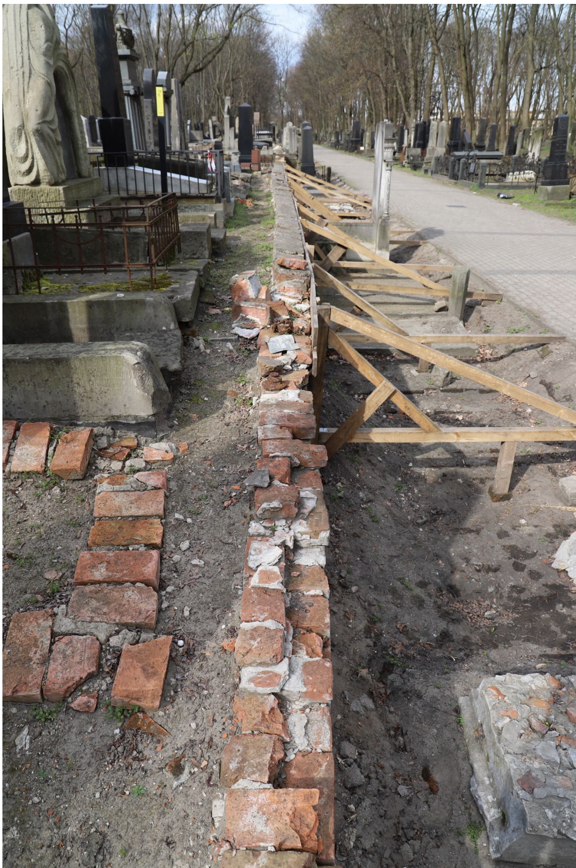
Foto. 5. Kwatera 19. Widok ogólny zwieńczenia muru nasypu wschodniego.
