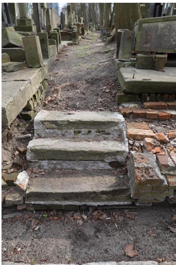
Foto. 102-104. Kwatera 24. Schody terenowe ściany północnej wykonane z macew ułożonych na cegłach uszczelnione w podstopnicach zaprawą cementową.
