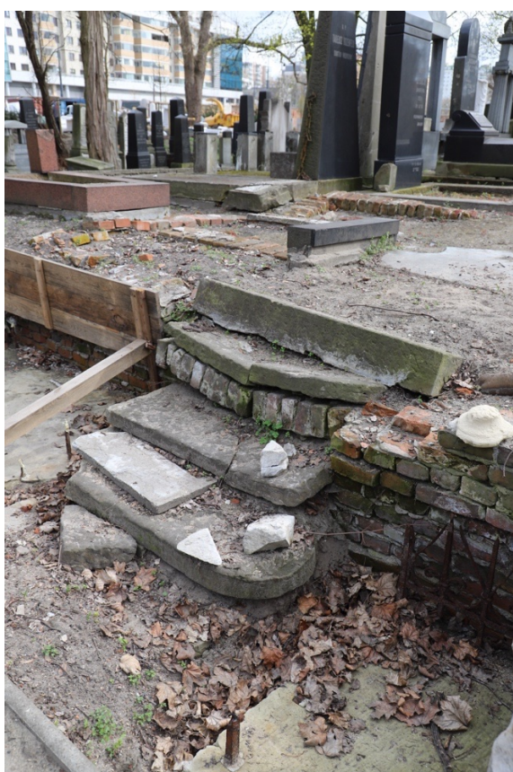
Foto. 32-34. Kwata 19, schody terenowe ściany północnej, wykonane z fragmentów macew jako stopnic i fragmentów cegieł tworzących podstopnice.
