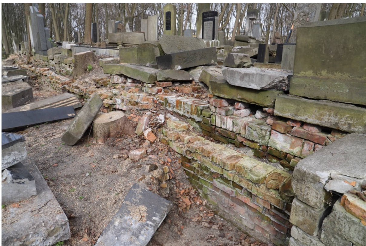
Foto. 174-175. Kwatera 31. Widok ogólny stanu zachowania fragmentu ściany zachodniej.
