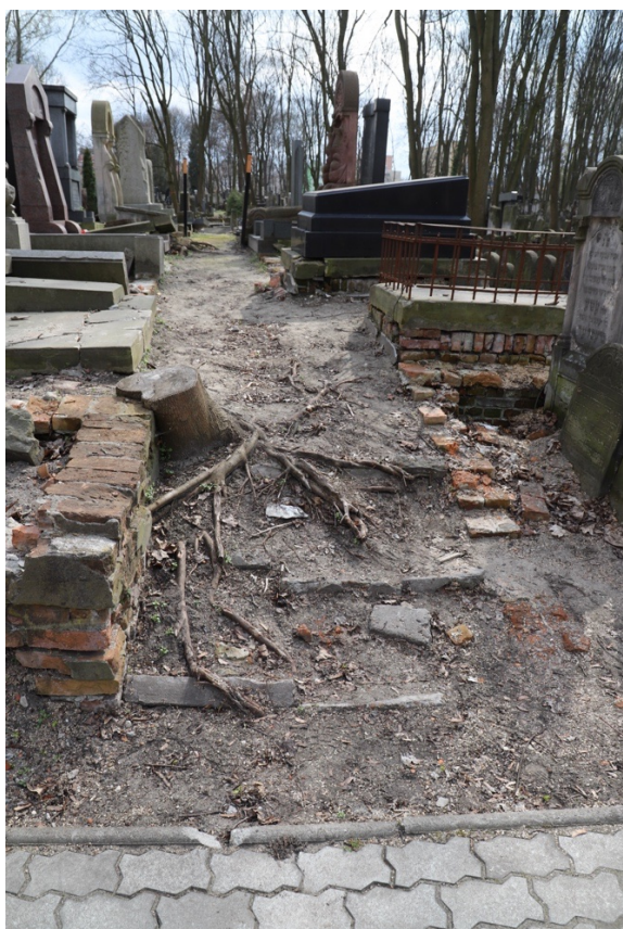
Foto. 35-37. Kwatera 19, schody terenowe ściany północnej przerośnięte przez korzeń, wykonane z fragmentów macew i elementów betonowych.
