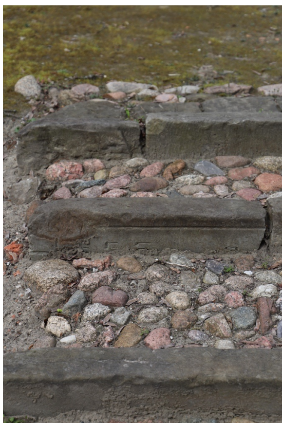
Foto. 29-31. Kwatera 19, schody terenowe ściany południowej wykonane z otoczaków ograniczonych fragmentami macew.
