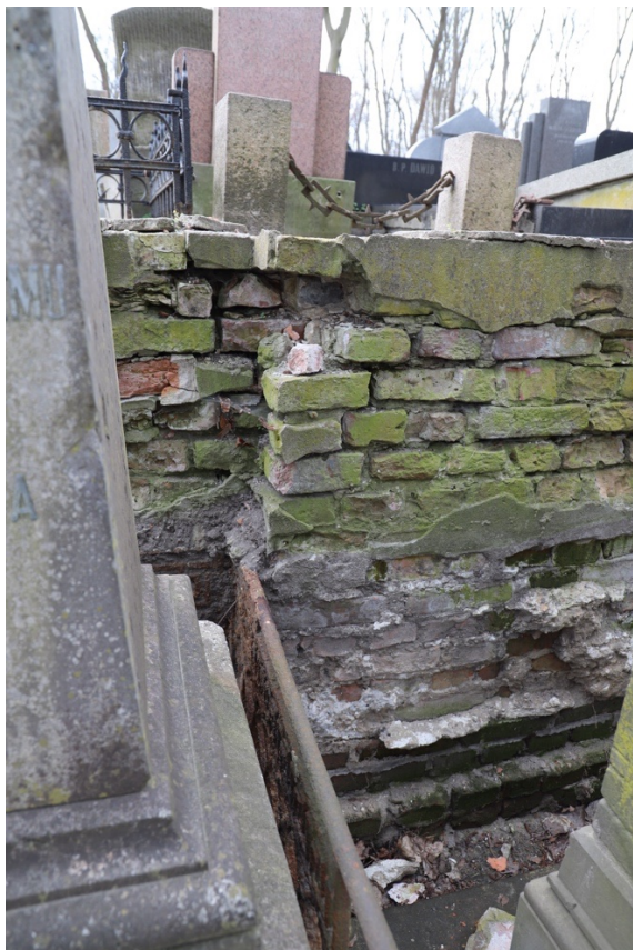
Foto. 51-54. Kwatera 24. Front muru wschodniego. Widoczne obudowywanie części składowych nagrobków oraz szczerzątkowo zachowane cementowe tynki, których spodnie krawędzie sięgają różnych wysokości.
