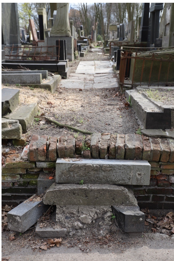
Foto. 99-101. Kwatera 24. Prowizoryczne schody ściany północnej wykonane z fragmentów nagrobków.
