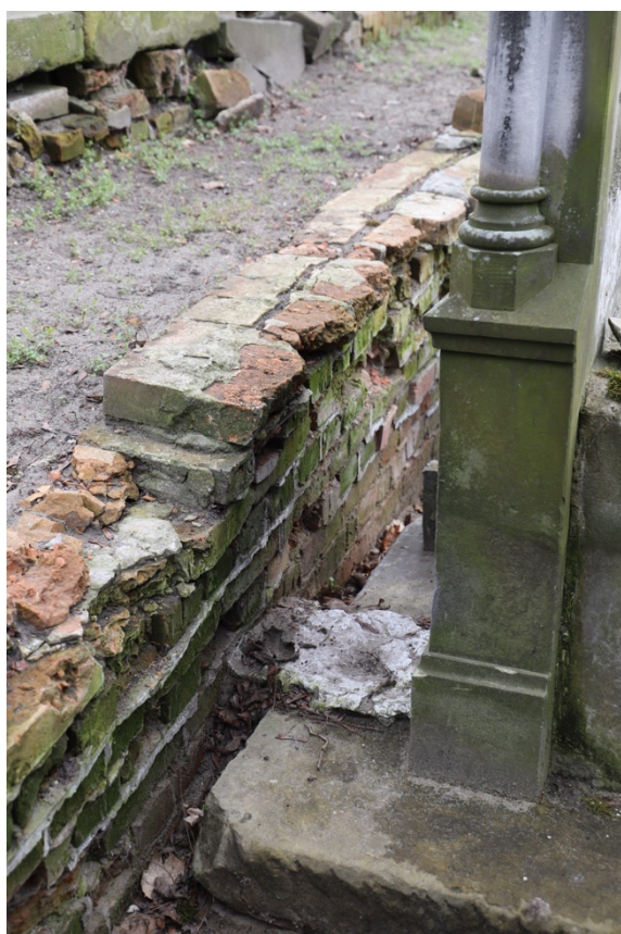
Foto. 75-78. Kwatera 24. Widok ogólny muru zachodniego z widocznymi odchyleniami od pionu i silnie zdestruowanymi cegłami.
