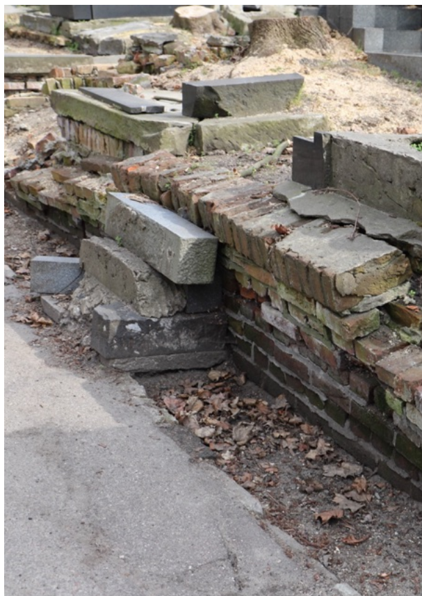
Foto. 99-101. Kwatera 24. Prowizoryczne schody ściany północnej wykonane z fragmentów nagrobków.
