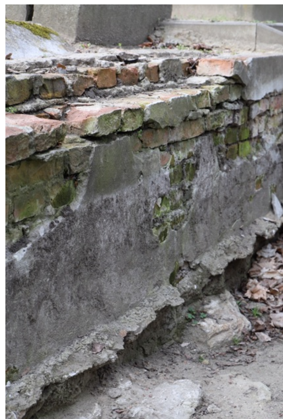
Foto. 132-135. Kwatera 31. Front muru wschodniego. Widoczne obudowywanie części składowych nagrobków oraz szczerunkowo zachowane cementowe zwieńczenie i tynki, których spodnie krawędzie sięgają różnych wysokości muru.
