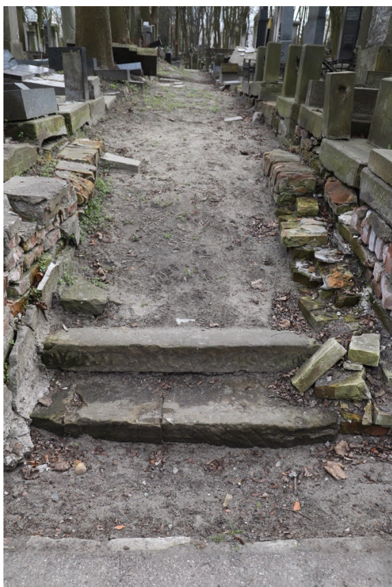
Foto. 108-110. Kwatera 24. Schody terenowe ściany północnej wykonane z fragmentów nagrobków..
