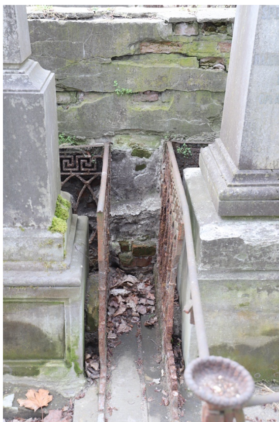
Foto. 56-59. Kwatera 24. Front muru wschodniego. Widoczne obudowywanie części składowych nagrobków oraz szczerunkowo zachowane cementowe tynki, których spodnie krawędzie sięgają różnych wysokości
