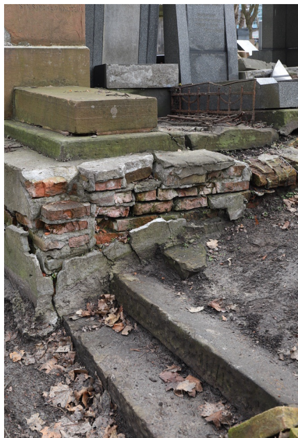
Foto. 108-110. Kwatera 24. Schody terenowe ściany północnej wykonane z fragmentów nagrobków..
