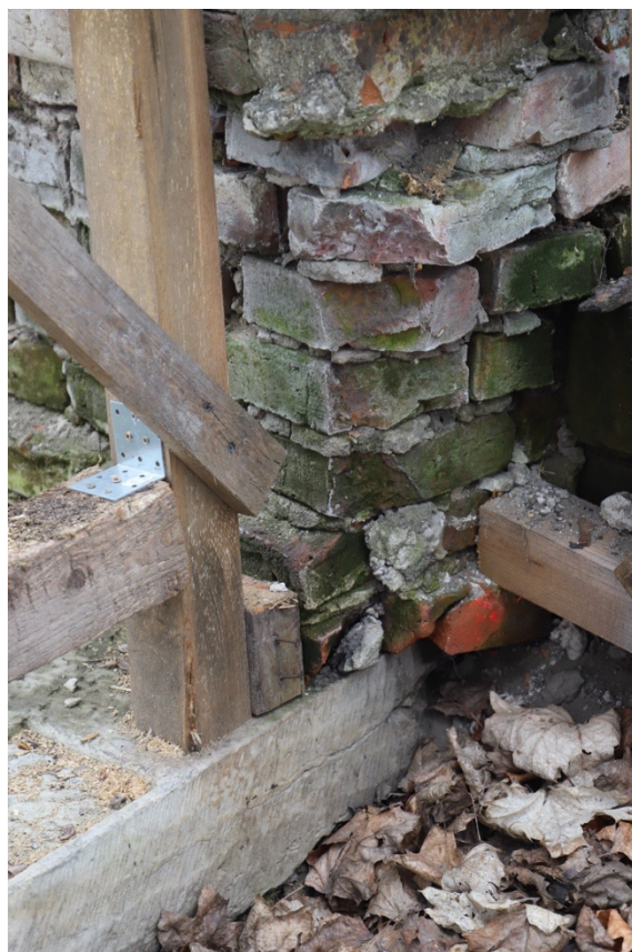
Foto. 6-10. Kwatera 19. Mur wschodni. Widoczne nabudowanie konstrukcji na elementach podstaw nagrobków.
