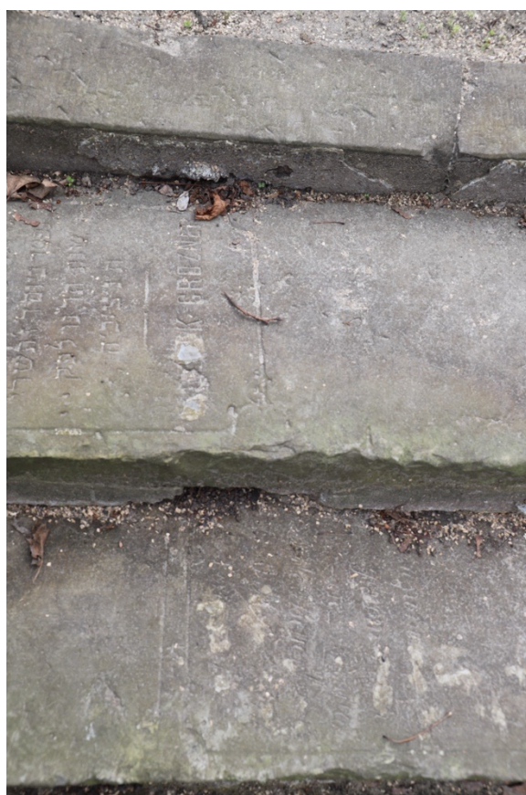
Foto. 105-107. Kwatera 24. Schody terenowe ściany północnej wykonane z macew ułożonych na cegłach.
