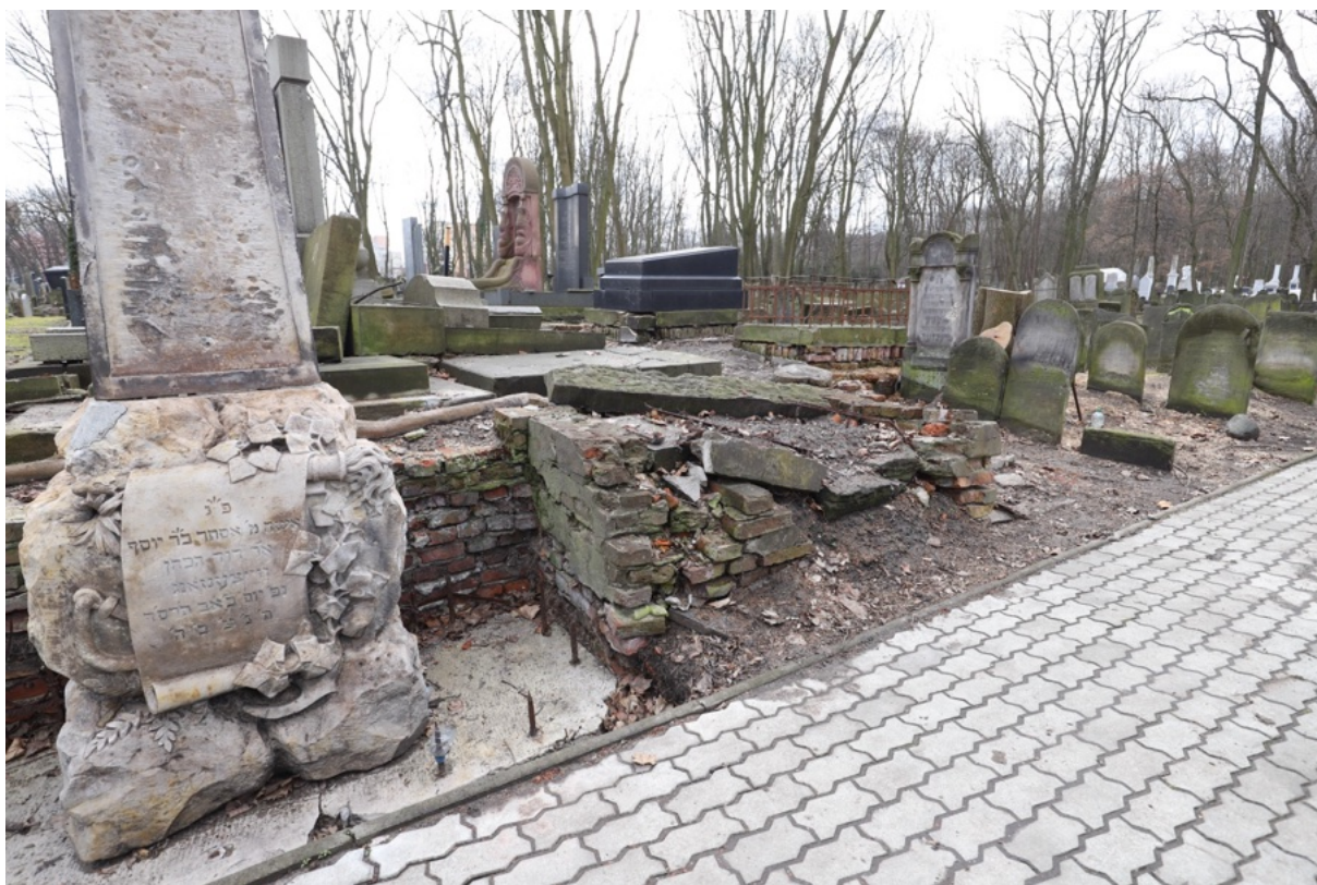
Foto. 24-25. Kwatera 19, widok ogólny fragmentu muru północnego.
