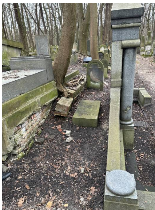
Fotografia nr. 15a,15b Zdjęcie [po lewej] przedstawia reprezentatywne uszkodzenia ceglanych murków. Fotografia [po prawej] przedstawia biologiczne oddziaływania negatywne na strukturę materiałową niskich murków ceglanych wokół kwater grzebalnych.
