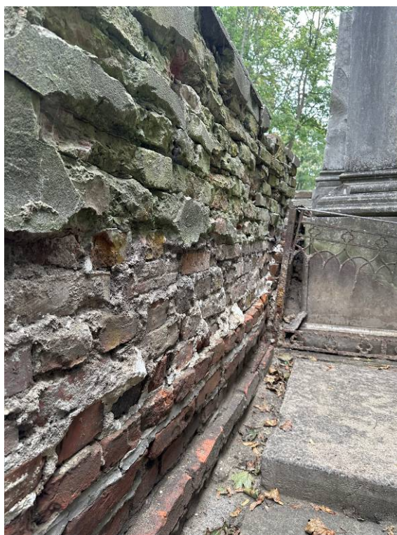
Fotografia nr. 11a, 11b Zdjęcia obrazujące reprezentatywne uszkodzenia murów oraz formę ich deformacji geometrycznej.
