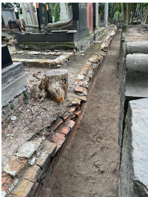
Fotografia nr. 13a, 13b Zdjęcia przedstawiające katastrofalny stan zachowania murków ceglanych wokół kwater grzebalnych.
