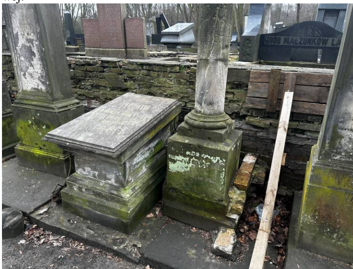
Fotografia nr. 5 Widok konstrukcji murowej stabilizowanej przez istniejące nagrobki.
