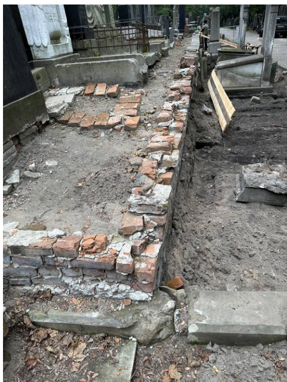
Fotografia nr. 11a, 11b Zdjęcia obrazujące reprezentatywne uszkodzenia murów oraz formę ich deformacji geometrycznej.
