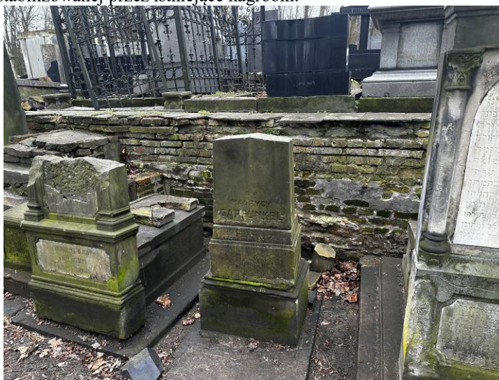
Fotografia nr. 6 Widok konstrukcji murowej stabilizowanej przez istniejące nagrobki.
