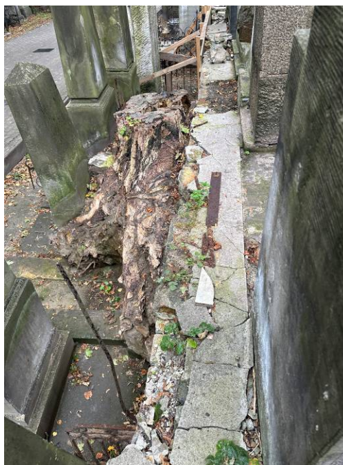
Fotografia nr. 12a, 12b Zdjęcie [po lewej] przedstawiające formę wzmocnienia ceglano murku poprzez dobudowaną przyporę, co nie uchroniło przed powstaniem uszkodzeń konstrukcyjnych. Zdjęcie [po prawej] przedstawia formę oddziaływania roślinności na zabudowę ceglano murków wokół kwater.
