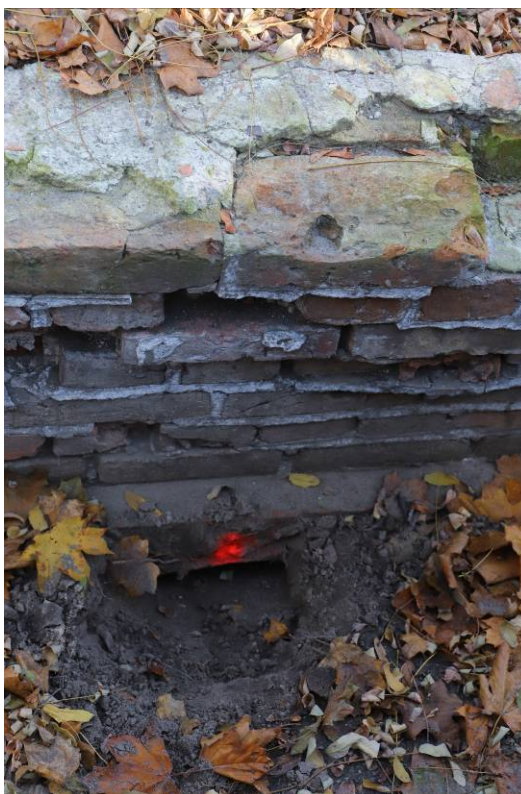
Fotografia nr. 16a,16b Zdjęcia przedstawiają wadę pierwotną związaną z zbyt płytkim posadowieniem ceglanych murków.
