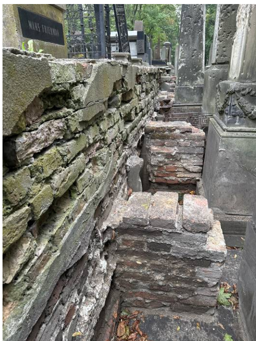
Fotografia nr. 12a, 12b Zdjęcie [po lewej] przedstawiające formę wzmocnienia ceglano murku poprzez dobudowaną przyporę, co nie uchroniło przed powstaniem uszkodzeń konstrukcyjnych. Zdjęcie [po prawej] przedstawia formę oddziaływania roślinności na zabudowę ceglano murków wokół kwater.
