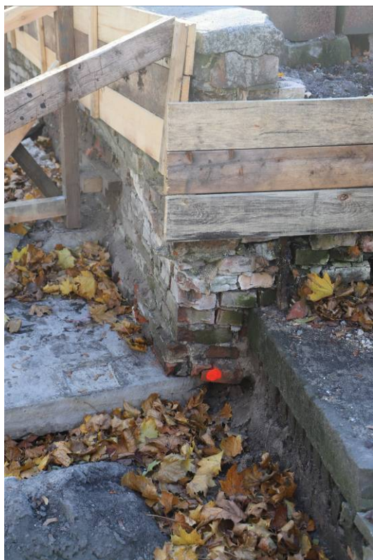
Fotografia nr. 16a,16b Zdjęcia przedstawiają wadę pierwotną związaną z zbyt płytkim posadowieniem ceglanych murków.
