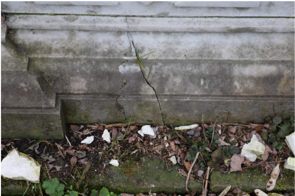
Foto 8, 9. Nagrobek Jakóba Eigera, pęknięcia konstrukcyjne w cokole . Fot Damian Pisarski, kwiecień 2023 r.
