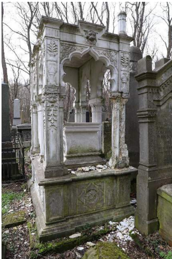
Foto 2,3,4,5, Nagrobek Jakóba Eigera, Widok ogólny z widocznymi intensywnymi nawarstwieniami biologicznymi i atmosferycznymi oraz postępującym rozpadem zrekonstruowanych elementów. Fot Damian Pisarski, kwiecień 2023 r.
