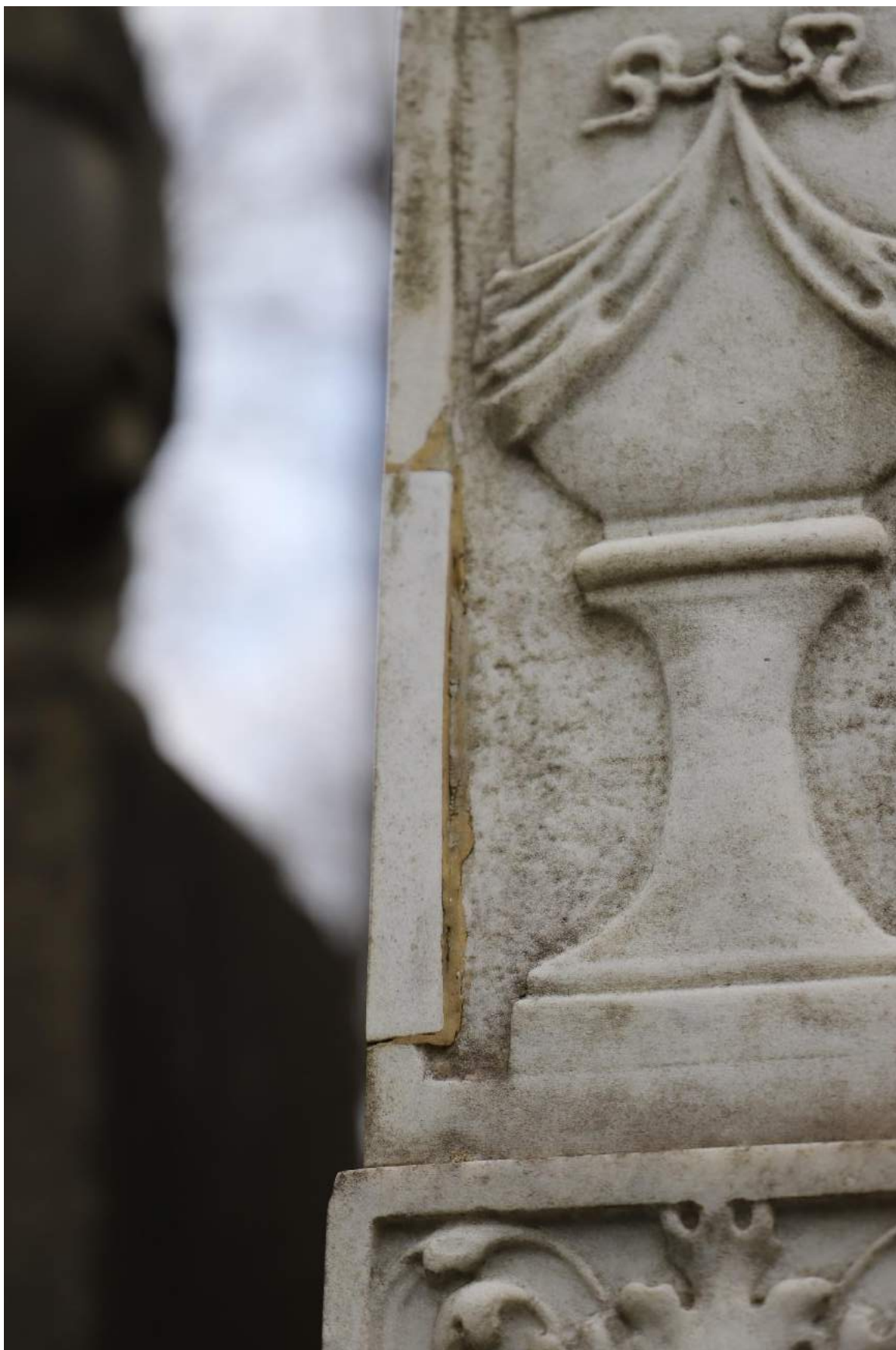
Foto 19. Nagrobek Jakóba Eigera, Wskutek postępujących procesów wietrzeniowych na powierzchni osłabionego kamienia zacierany jest detal rzeźbiarski. Po lewej stronie widoczny żółtknięty, wykruszający się klej na który wmontowano kamienne uzupełnienie. Fot Damian Pisarski, kwiecień 2023 r
