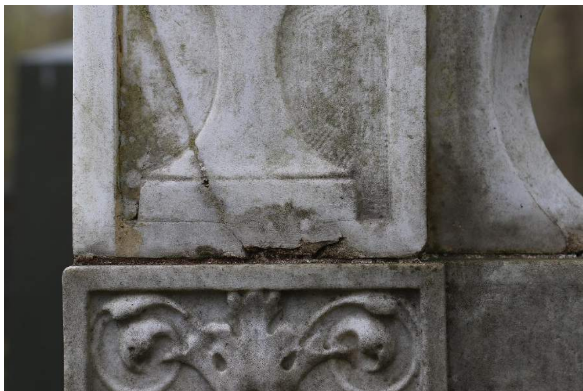
Foto 20, 21, 22 Nagrobek Jakóba Eigera, zwietrzałe, wykruszające się i żółknięte uzupełnienia.. Fot Damian Pisarski, kwiecień 2023 r
