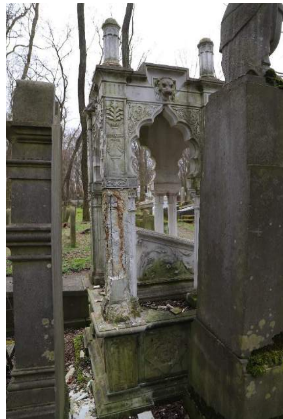
Foto 2,3,4,5, Nagrobek Jakóba Eigera, Widok ogólny z widocznymi intensywnymi nawarstwieniami biologicznymi i atmosferycznymi oraz postępującym rozpadem zrekonstruowanych elementów. Fot Damian Pisarski, kwiecień 2023 r.
