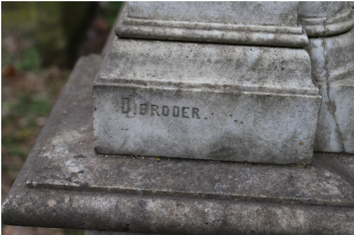
Foto 6. Nagrobek Jakóba Eigera, baza przedniej podpory z sygnaturą widoczne postępujące nawarstwienia i biologiczno-chemiczne oraz pęknięcia. Wskutek postępujących procesów wietrzeniowych na powierzchni osłabionego kamienia zacierany jest detal rzeźbiarski. Fot Damian Pisarski, kwiecień 2023 r.
