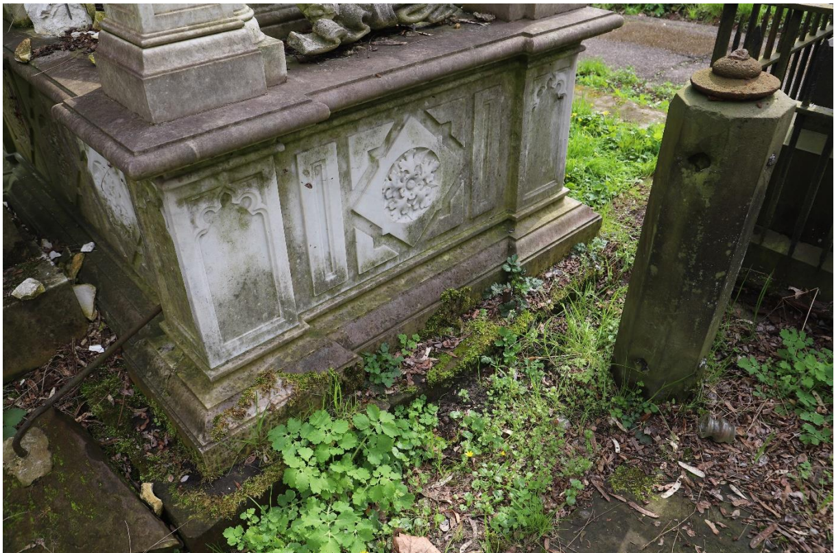
Foto 23,24, Nagrobek Jakóba Eigera, najniższe partie obiektu intensywnie porośnięte roślinnością . Fot Damian Pisarski, kwiecień 2023 r
