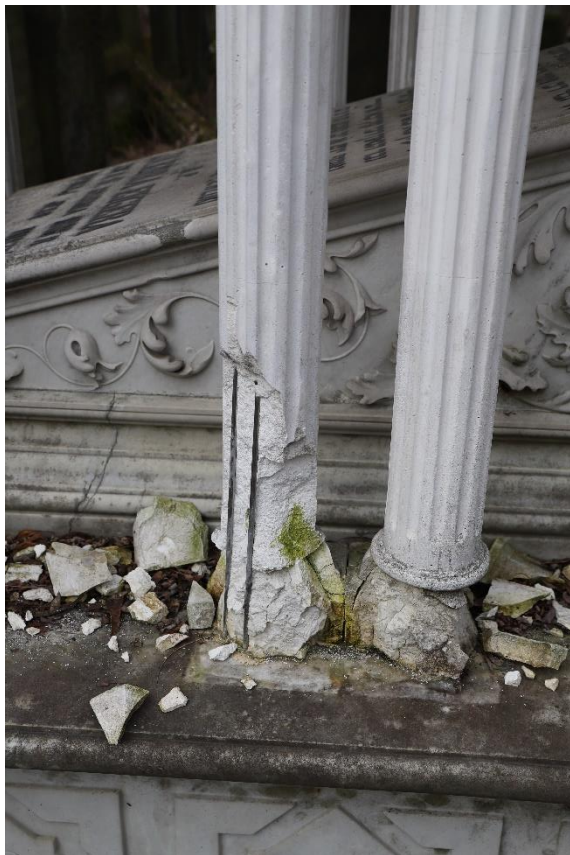
Foto 12, 13,14. Nagrobek Jakóba Eigera, bardzo zaawansowany rozpad zrekonstruowanych elementów konstrukcyjnych dźwigających najwyższe elementy. Bardzo szybko postępujący rozpad połowy ze wszystkich podpór może doprowadzić do powalenia konstrukcji. Fot. Damian Pisarski, kwiecień 2023 r.
