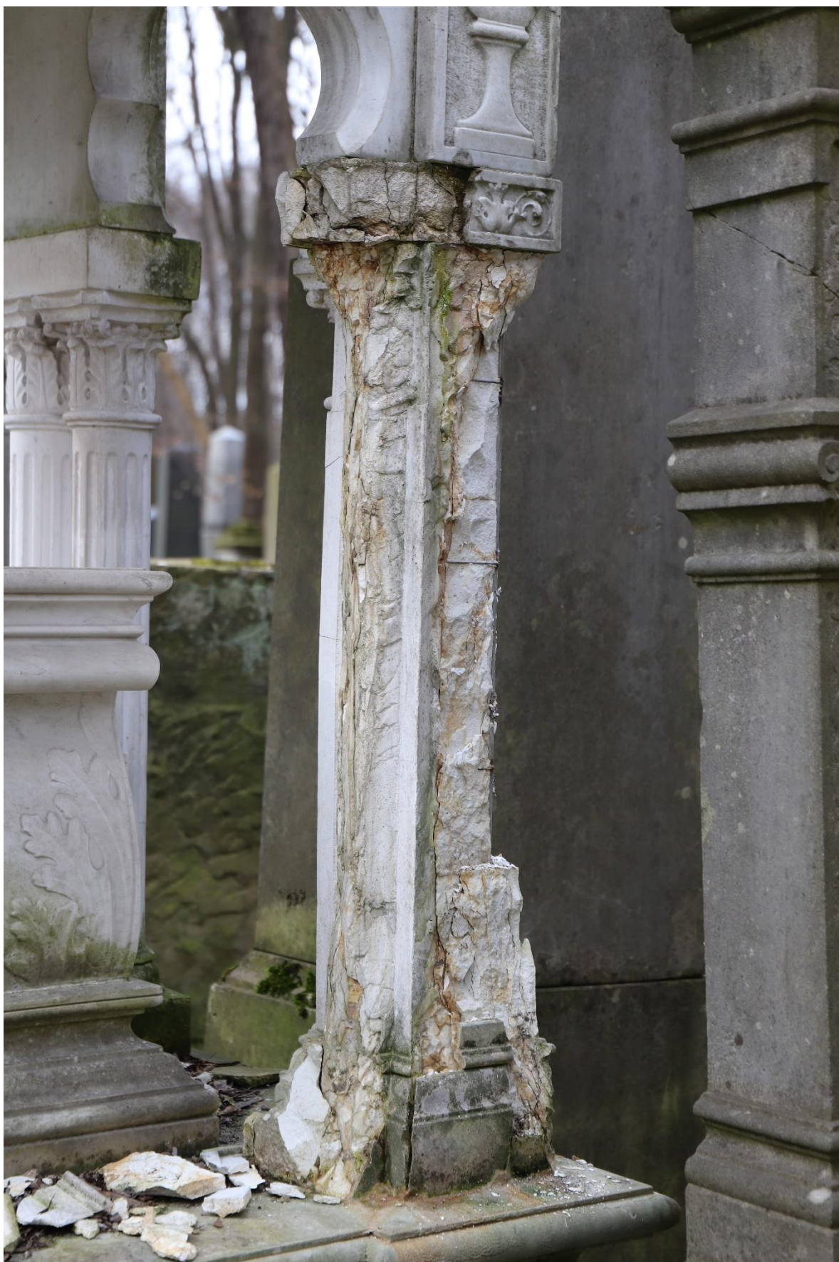
Foto 15. Nagrobek Jakóba Eigera, zaawansowany rozpad jednej ze zrekonstruowanych podpór. Bardzo szybko postępujący rozpad połowy ze wszystkich podpór może doprowadzić do powalenia konstrukcji. Fot Damian Pisarski, kwiecień 2023 r.
