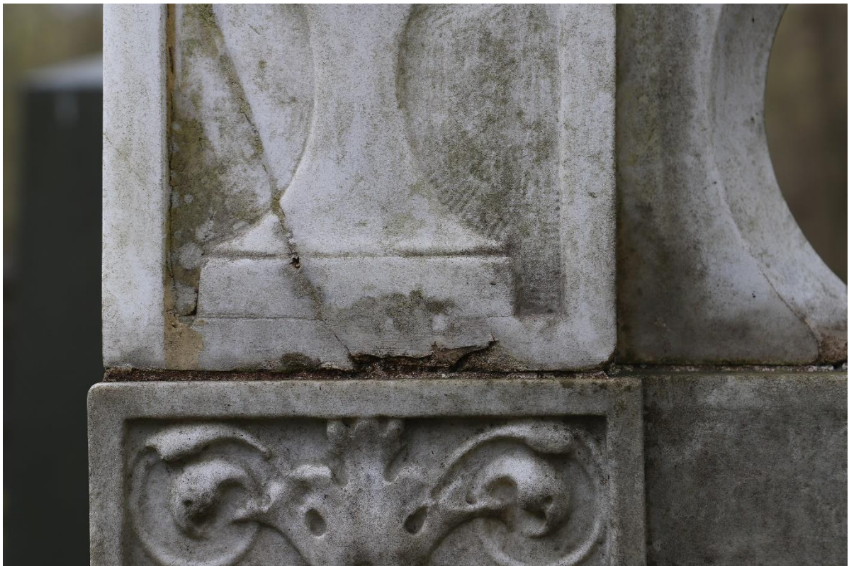
Foto 20, 21, 22 Nagrobek Jakóba Eigera, zwierzęta, wykuszające się i żółknięte uzupełnienia.. Fot Damian Pisarski, kwiecień 2023 r
