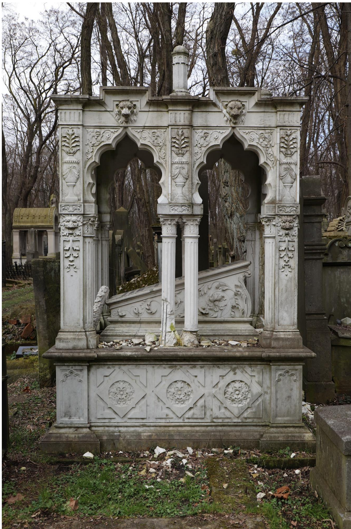
Foto 1. Nagrobek Jakóba Eigera, Widok ogólny z widocznymi intensywnymi nawarstwieniami biologicznymi i atmosferycznymi oraz postępującym rozpadem zrekonstruowanych elementów. Fot Damian Pisarski, kwiecień 2023 r.
