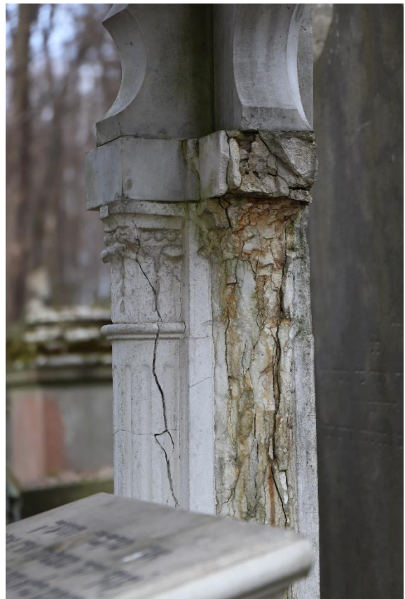
Foto 12, 13,14. Nagrobek Jakóba Eigera, bardzo zaawansowany rozpad zrekonstruowanych elementów konstrukcyjnych dźwigających najwyższe elementy. Bardzo szybko postępujący rozpad połowy ze wszystkich podpór może doprowadzić do powalenia konstrukcji. Fot. Damian Pisarski, kwiecień 2023 r.
