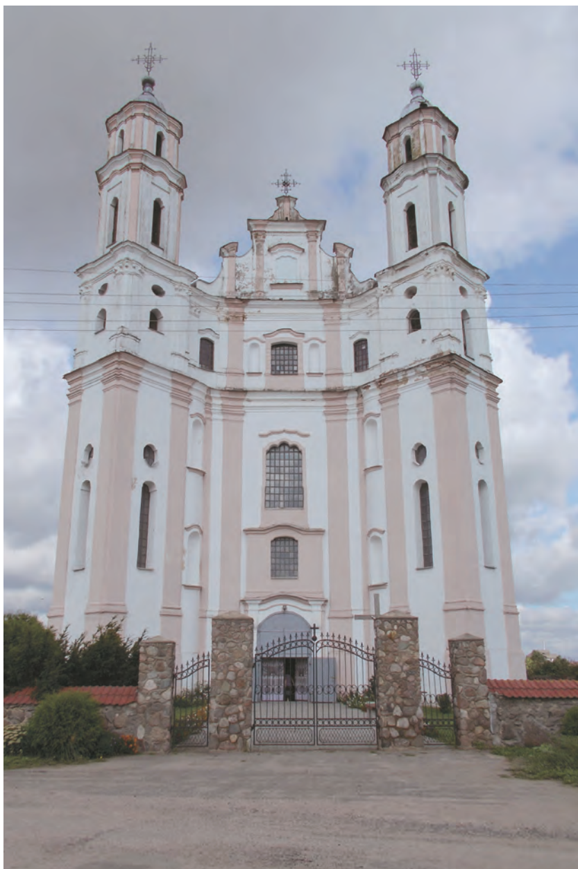
Kościół w Łużkach po zakończonych pracach przy stabilizacji krzyża. Fot. K. Patejuk
