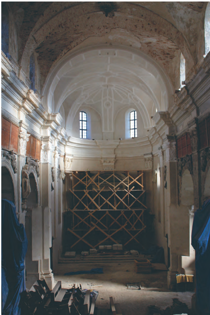
Nawa główna przed i po pracach konserwatorskich. Fot. J. Rosiak
