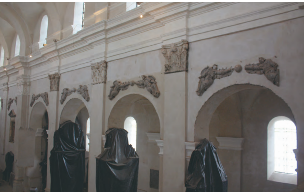
Nawa główna. Stan po i w trakcie prac konserwatorskich. Fot. J. Rosiak
