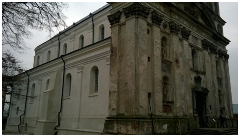
Elewacja boczna po zakończonych pracach
