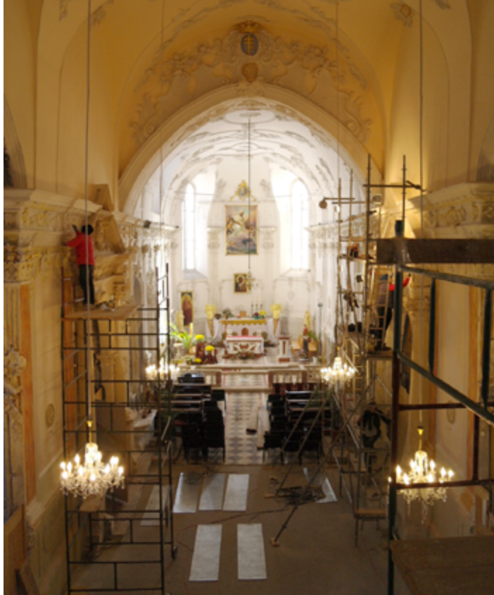
Widok nawy głównej podczas prac konserwatorsko-restauratorskich
