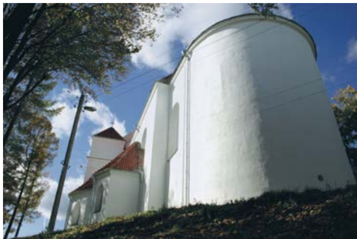
Fara Witoldowa w Nowogródku po zakończeniu prac konserwatorskich przy elewacji
