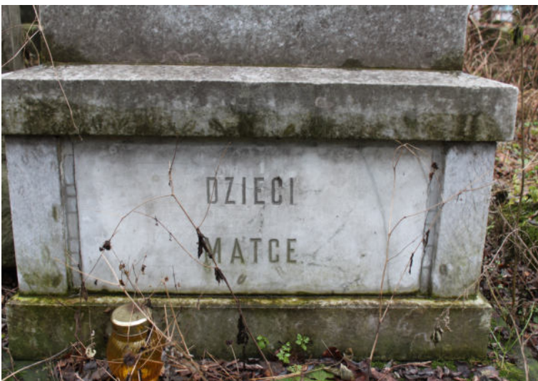
Fot. Wtórne uzupełnienia ubytków i spoin.
