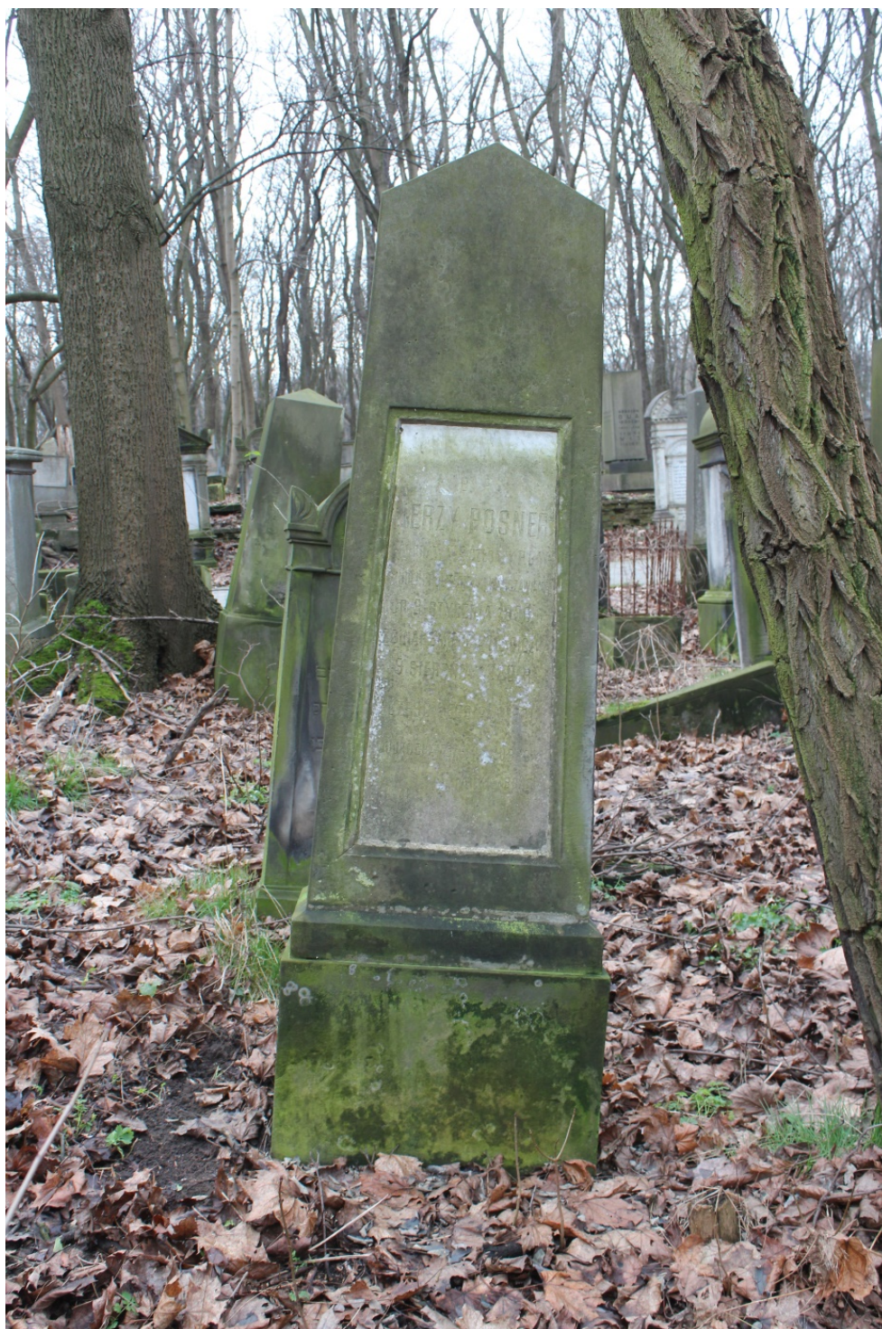
Foto. 1. Nagrobek Jerzego Posnera [sektor 66, rząd 5, nr 11]. Widok ogólny. Widoczne przechylenie obiektu oraz silne nawarstwienia biologiczno-chemiczne. Fot. Damian Pisarski. 2018r.
