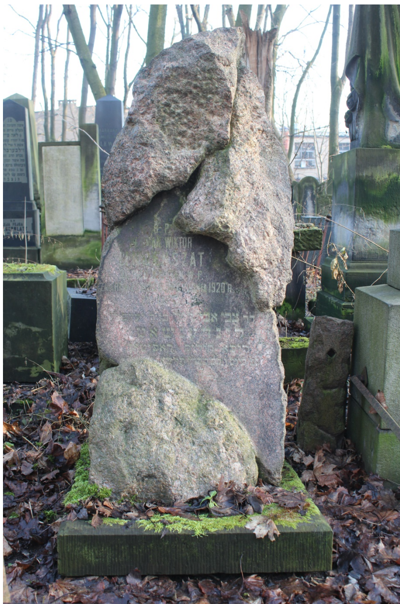
Foto. 1 Nagrobek Hermana Wiktora Lindenszat [sektor 64a, rząd 1, nr 4]. Widok ogólny. Widoczne silne nawarstwienia biologiczno-chemiczne dolnych partii obiektu. Fot. Damian Pisarski. 2018r.
