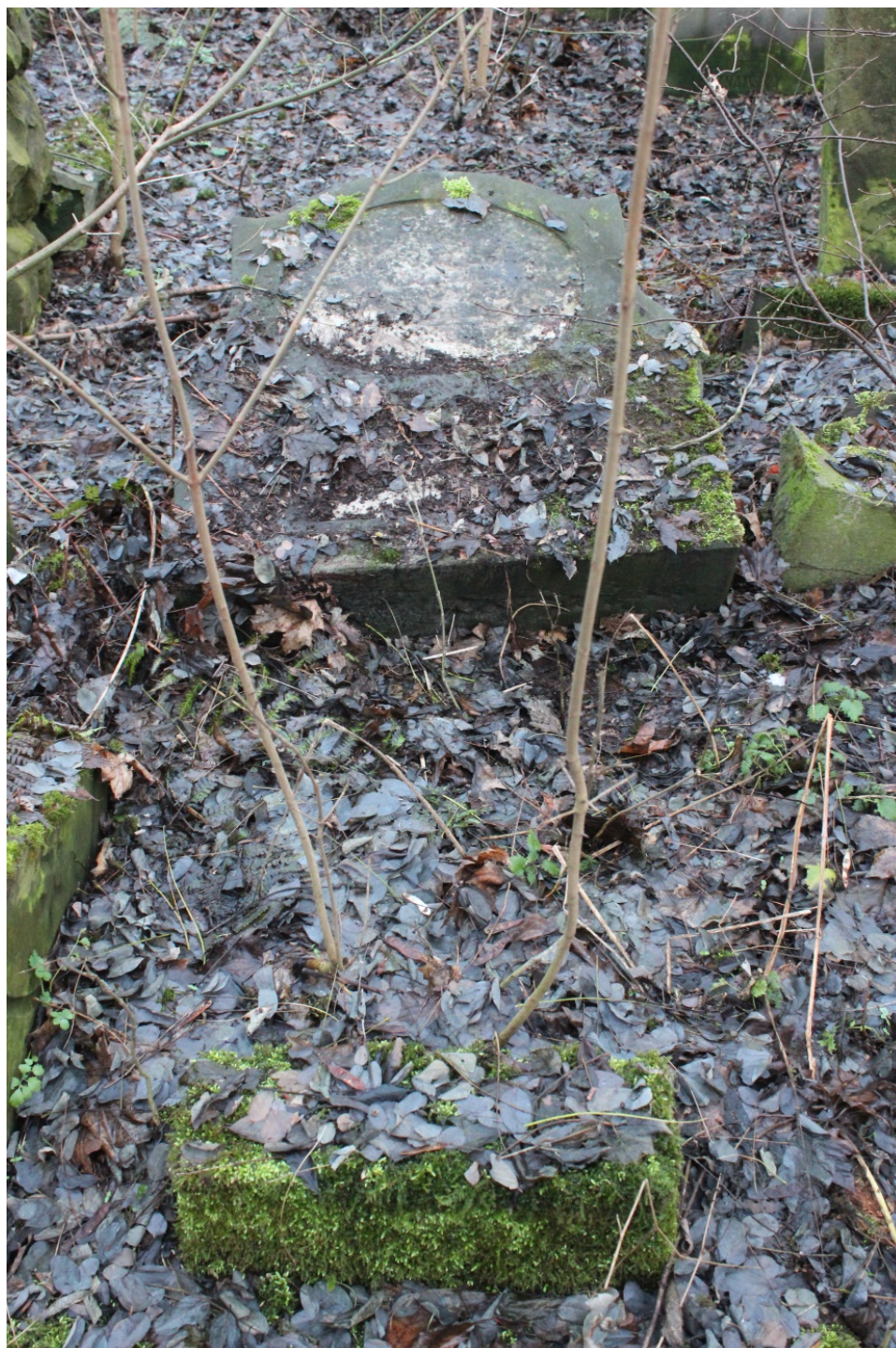
Foto. 1. Nagrobek Mieczysława Zandsznajdera [sektor 22, rząd 23, numer 6 ]. Widok ogólny. Przechylony obiekt, pokryty biologiczno-chemicznymi nawarstwieniami . pole grobowe zakryte ziemią i humusem. Fot. D. Pisarski, 2017r.
