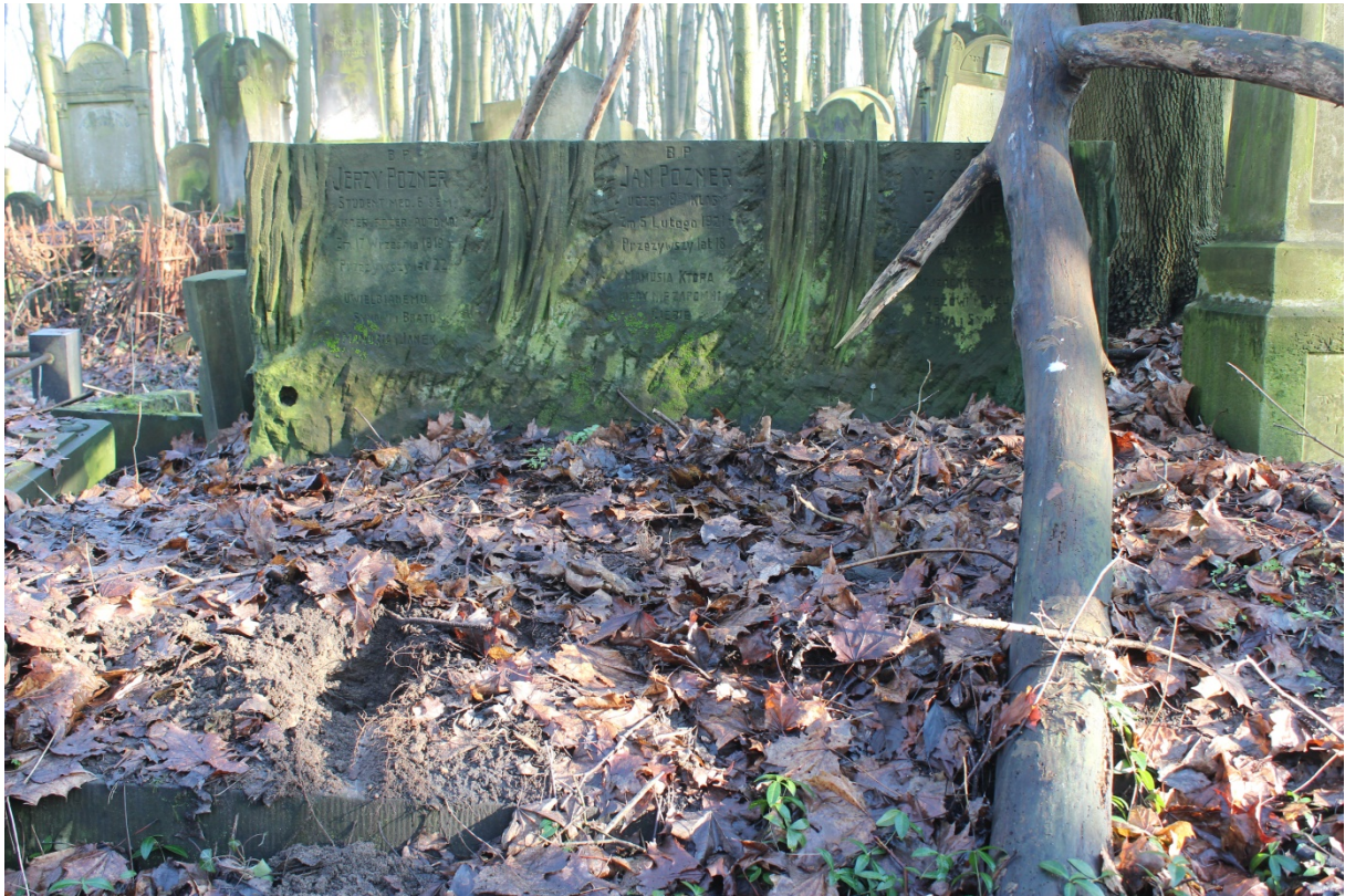
Foto. 1. Nagrobek Jerzego Pozniera [sektor 52, rząd 2, nr 21]. Widok ogólny. Widoczne silne nawarstwienia biologiczno-chemiczne oraz zasypanie pola grobowego grubą warstwą ziemi i humusu. Fot. Damian Pisarski. 2017r.
