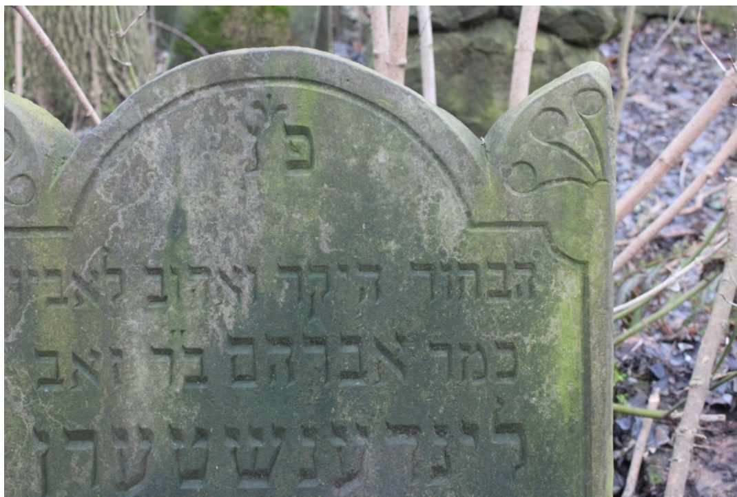
Foto. 3. Nagrobek Aleksandra Lindensterna [sektor 22, rząd 23, nr 4]. Detal. Nawarstwienia biologiczno-chemiczne. Fot. D. Pisarski, 2017 r.
