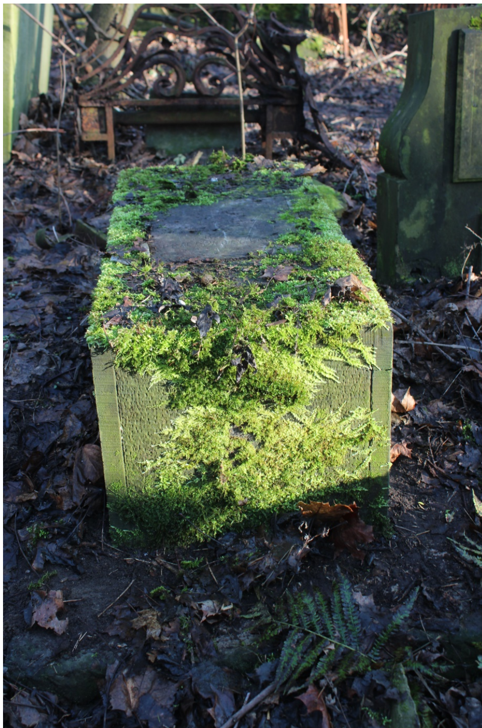
Foto. 1. Nagrobek Jerzego Frenkiela [sektor 52, rząd 2, nr 17]. Widok ogólny. Widoczne silne nawarstwienia biologiczno-chemiczne. Fot. Damian Pisarski. 2017r.
