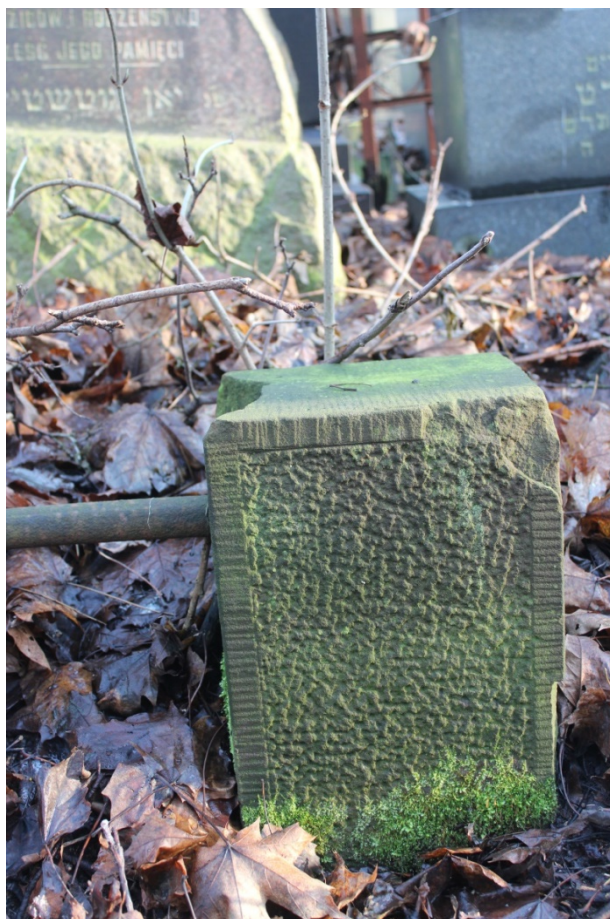
Foto. 2. Nagrobek Jana Gutszteina [sektor 44b/ rząd 2/ nr 7]. Detal. słupek ogrodzenia z ubytkami formy i nawarstwieniami. Fot. D. Pisarski, 2017 r.
