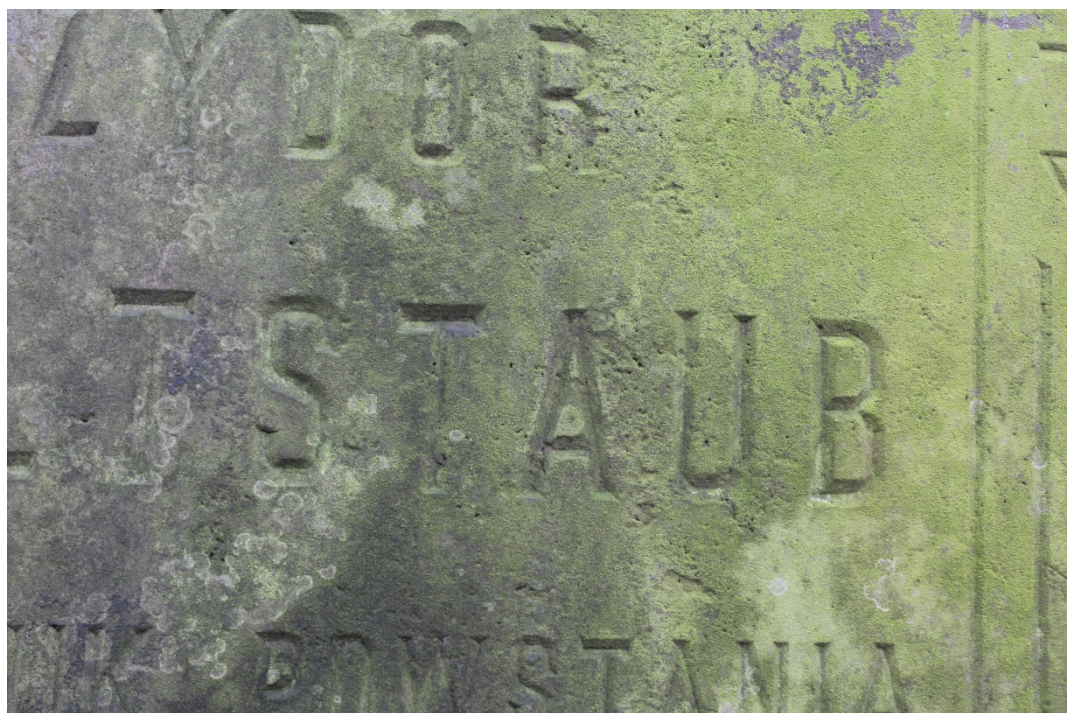
Foto. 3. Nagrobek Izydora Weltstaub [sektor 65, rząd 5, nr 52]. Detal. Zwietrzała powierzchnia obiektu, pokryta biologiczno-chemicznymi nawarstwieniami. Fot. Damian Pisarski. 2018r.
