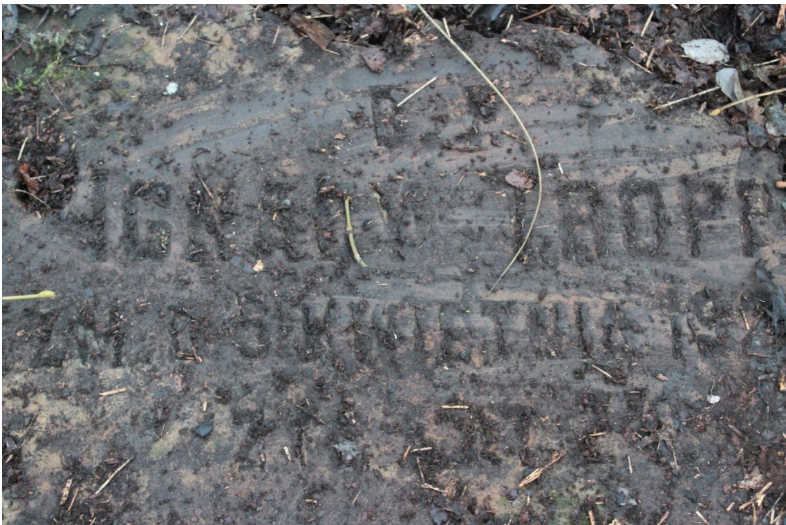
Foto. 3. Nagrobek Ignacego Troppa [sektor 22, rząd 23, nr 5]. Detal. Zwietrzała, osłabiona powierzchnia płyty inskrypcyjnej. Fot. D. Pisarski, 2017 r.
