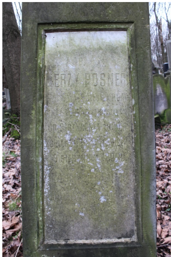
Foto. 2. Nagrobek Jerzego Posnera [sektor 66, rząd 5, nr 11]. Detal . Widoczne silne nawarstwienia biologiczno-chemiczne na powierzchni marmurowej płyty. Fot. Damian Pisarski. 2018r.
