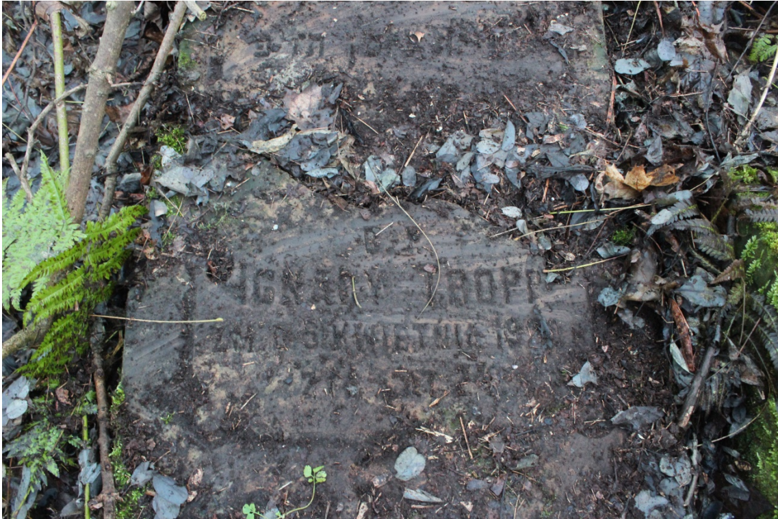
Foto. 2. Nagrobek Ignacego Troppa [sektor 22, rząd 23, nr 5]. Detal obiektu z biologiczno-chemicznymi nawarstwieniami. Widoczne pęknięcie płyty i przemieszczenie jej części. Fot. D. Pisarski, 2017 r.
