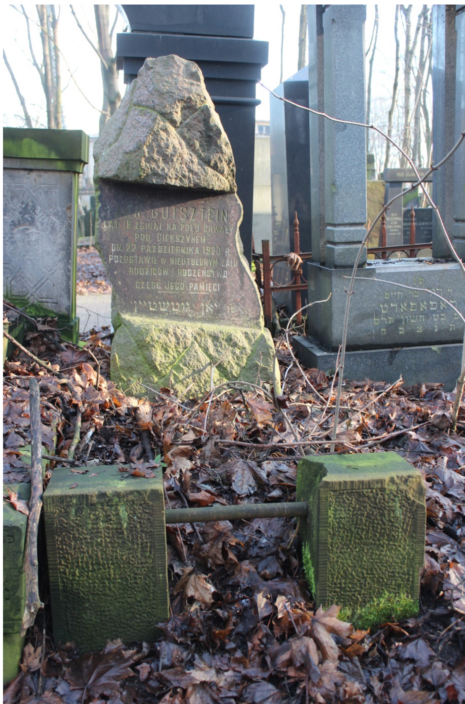
Foto. 1. Nagrobek Jana Gutszteina [sektor 44b/ rząd 2/ nr 7]. Widok ogólny obiektu z przykrytym ziemią i humusem polem grobowym, nawarstwieniami oraz ubytkami słupków ogrodzenia.
