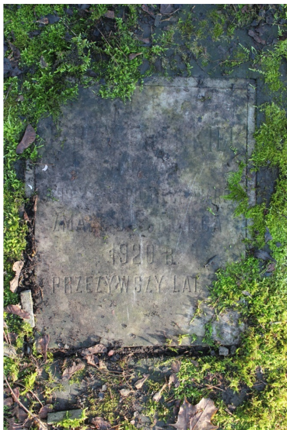
Foto. 2 Nagrobek Jerzego Frenkiela [sektor 52, rząd 2, nr 17]. Detal . Widoczne silne nawarstwienia biologiczno-chemiczne oraz zwietrzała płyta marmurowa z inskrypcją. Fot. Damian Pisarski. 2017r
