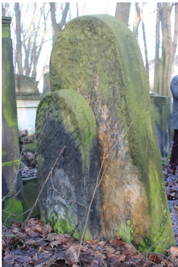
Foto. 2. Nagrobek Izydora Weltstaub [sektor 65, rząd 5, nr 52]. Widok ogólny, tył. Widoczne przechylenie obiektu oraz silne nawarstwienia biologiczno-chemiczne. Fot. Damian Pisarski. 2018r.
