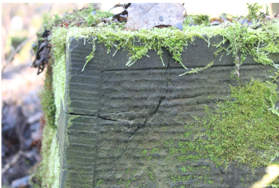
Foto. 3. Nagrobek Jerzego Frenkiela [sektor 52, rząd 2, nr 17]. Detal. Widoczne silne nawarstwienia biologiczno-chemiczne oraz spękania . Fot. Damian Pisarski. 2017r
