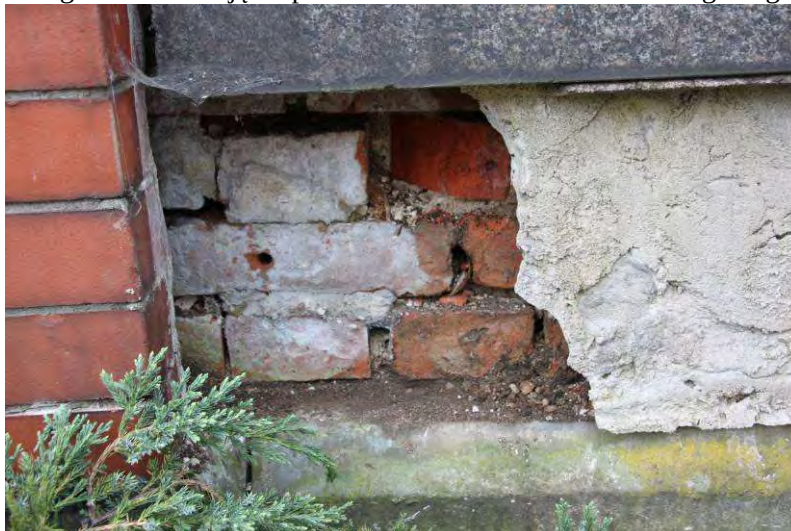
Fotografia nr. 5 Zdjęcie przedstawia wykonaną odkrywkę.
