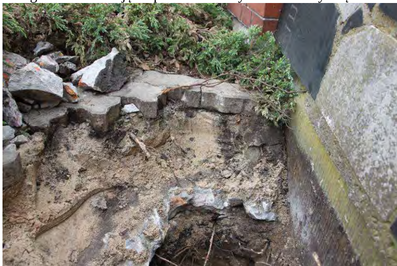
Fotografia nr. 11 Zdjęcie przedstawia zbliżenie na układ warstw przy murze oporowym.
