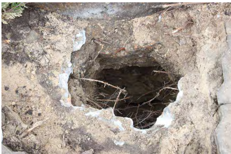
Fotografia nr. 12 Zdjęcie przedstawia odkrywkę wraz z ze zbliżeniem na rodzaj muru oporowego części podziemnej.
