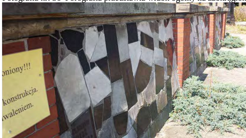
Fotografia nr. 37 Fotografia przedstawia sposób wykończenia powierzchni przęsła. Widoczne pochylenie powierzchni warstwy wykończeniowej nawiązującego do pierwotnego rozwiązania technicznego.
