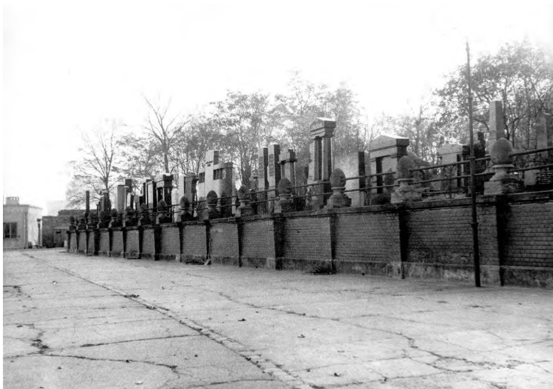
Fotografia nr. A przedstawia archiwalny wygląd muru oporowego przy kwaterach od strony wejścia na cmentarz.
