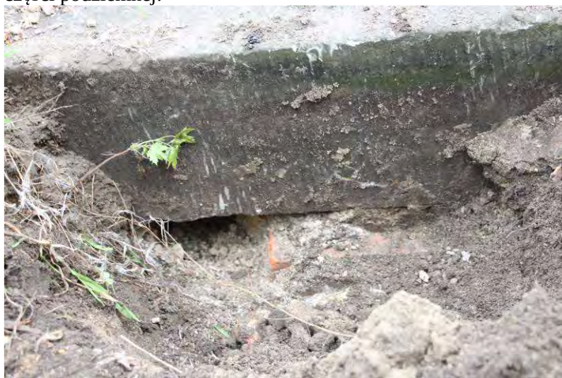
Fotografia nr. 13 Zdjęcie przedstawia zakończenie zakrywy kamiennej na koronie muru oporowego.
