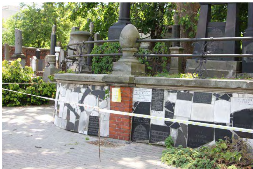
Fotografia nr. 36 Fotografia przedstawia widok ogólny na zaokrąglone zakończenie muru oporowego.
