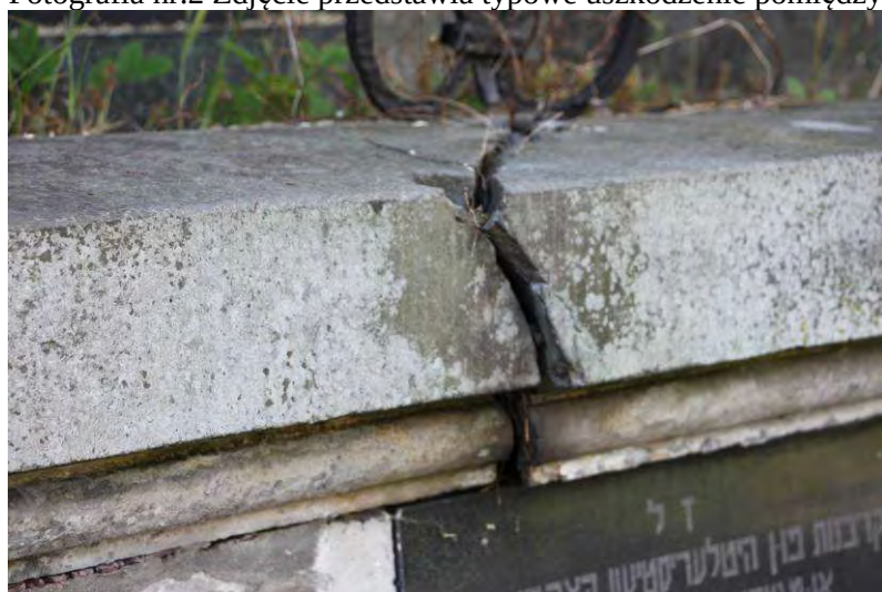
Fotografia nr. 3 Zdjęcie przedstawia przykład reprezentatywnego uszkodzenia kamiennego zakończenia muru oporowego.
