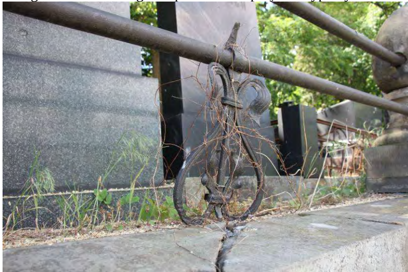
Fotografia nr. 24 Fotografia przedstawia przykład typowych uszkodzeń detalu stalowego.
