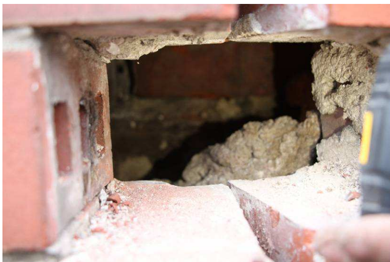
Fotografia nr. 9 Fotografia pokazuje wykonaną odkrywkę. Wykonany filarek jest elementem dobudowanym do ceglanego muru oporowego.
