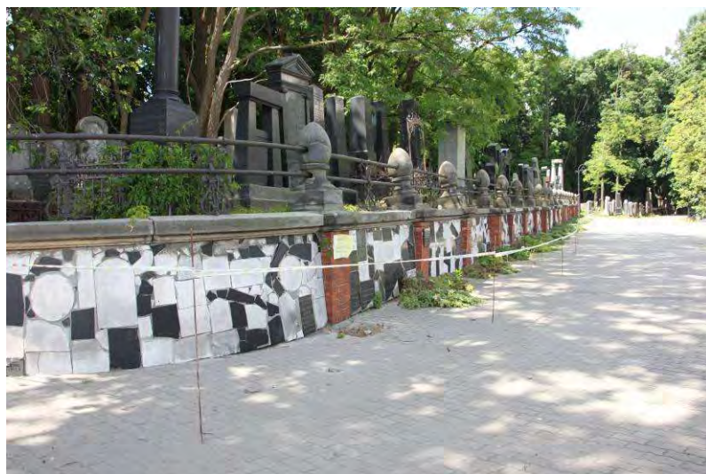
Fotografia nr.1 Zdjęcie przedstawia widok muru oporowego przy wejściu na cmentarz.
