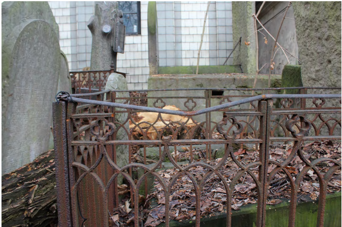
Foto. 3. Nagrobek Israela Asher Mendelzona [sektor 1, rząd 6, nr 14]. Detal. Ubytki i zniszczenia w skorodowanym ogrodzeniu. Fot. D. Pisarski 2017r.
