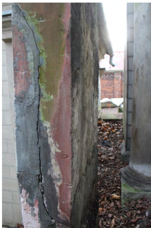
Foto. 2. Nagrobek Avrahama Tzvi Perlmutter [sektor 1, rząd 5, nr 12]. Detal, odspojonej, silnie zwietrzałej marmurowej płyty inskrypcyjnej z ołowianą inskrypcją. Fot. D. Pisarski 2017 r.
