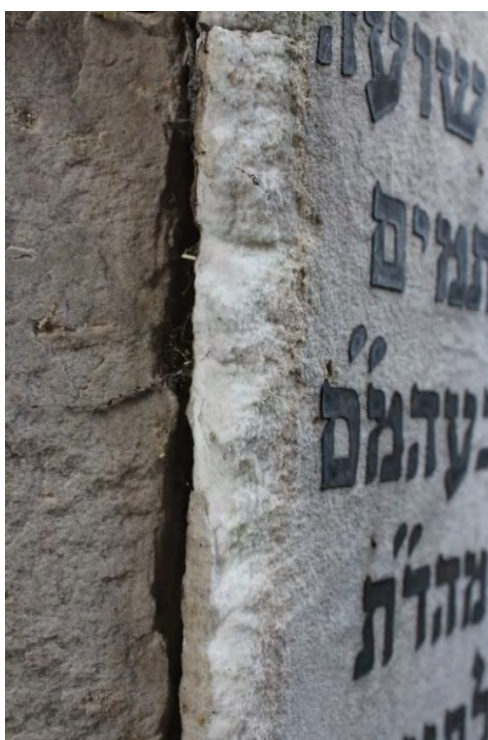
Foto. 2. Nagrobek Avrahama Tzvi Perlmutter [sektor 1, rząd 5, nr 12]. Detal, odspojonej, silnie zwietrzałej marmurowej płyty inskrypcyjnej z ołowianą inskrypcją. Fot. D. Pisarski 2017 r.
