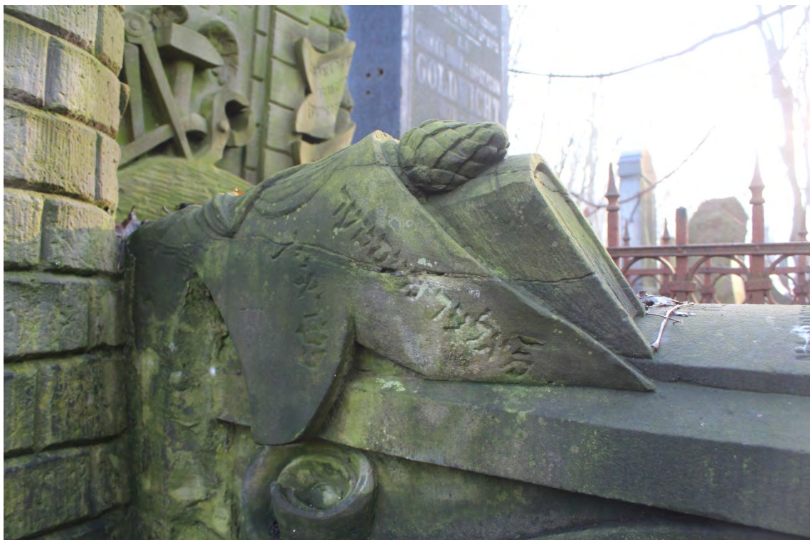
Foto. 3. Nagrobek Abrahama Cwajusa [sektor 44, rząd 2, nr 6]. Detal, widoczne wtórne uzupełnienia, spękania i biologiczno-chemiczne nawarstwienia. Fot. D. Pisarski 2017r.
