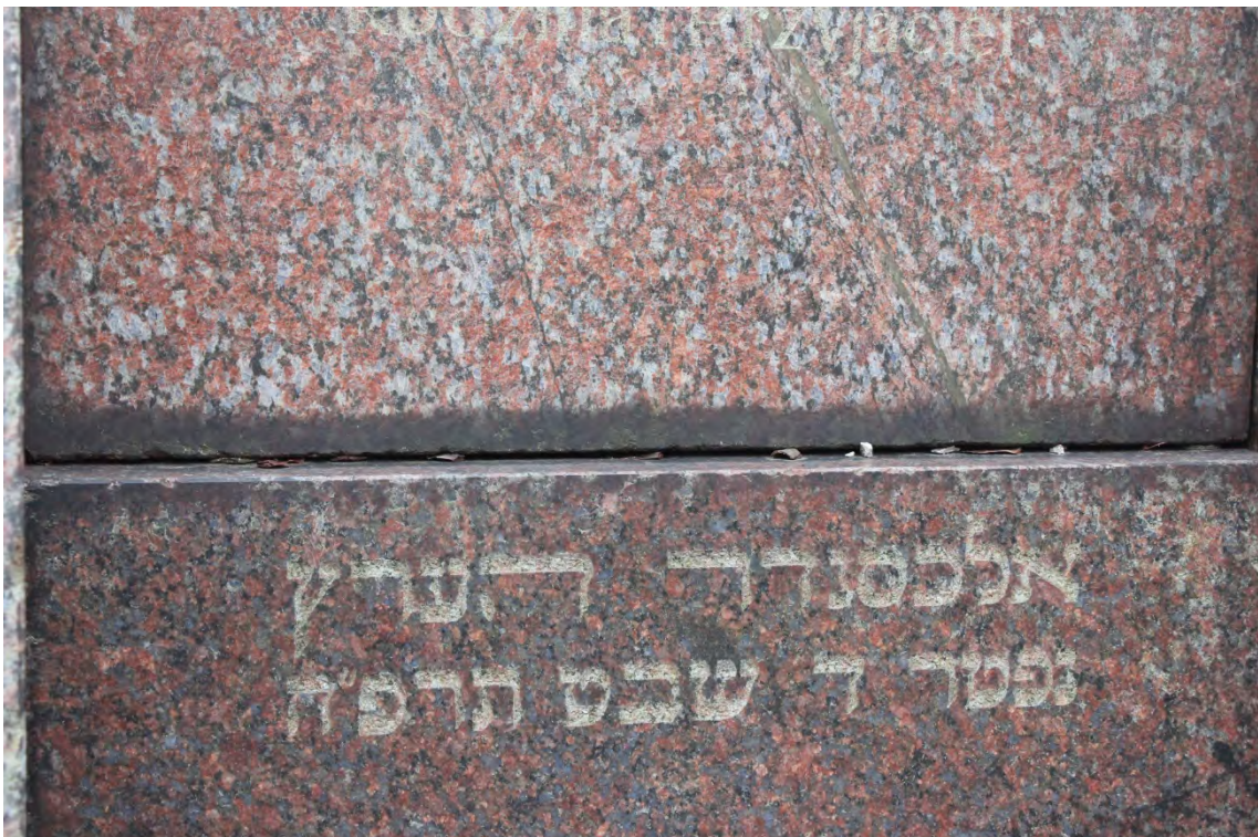
Foto. 3. Nagrobek Aleksandra Hertza [sektor 19, rząd 5, numer 2]. Detal. Widoczny brak spoinowania. Fot. D. Pisarski, 2017 r.
