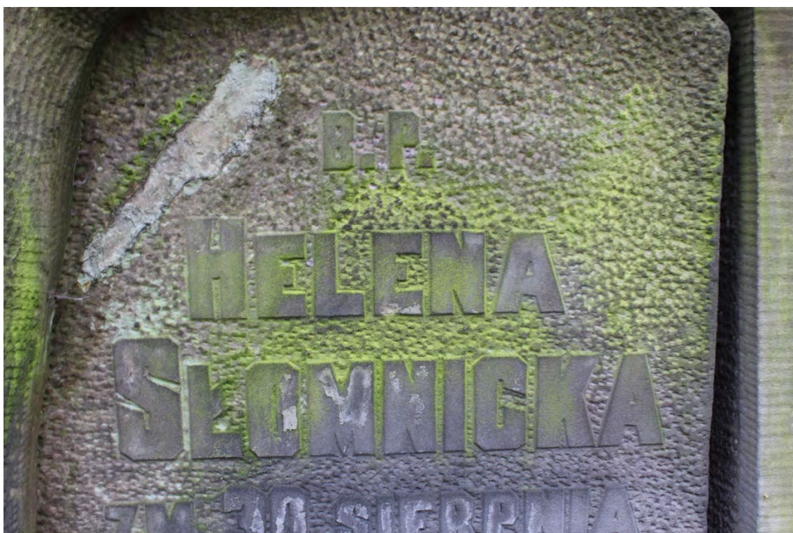
Foto. 2. Nagrobek Heleny Słomnickiej [sektor 12b, rząd 11, nr 10]. Detal. Wtórne uzupełnienia i biologiczno-chemiczne nawarstwienia. Fot. D. Pisarski, 2017r.
