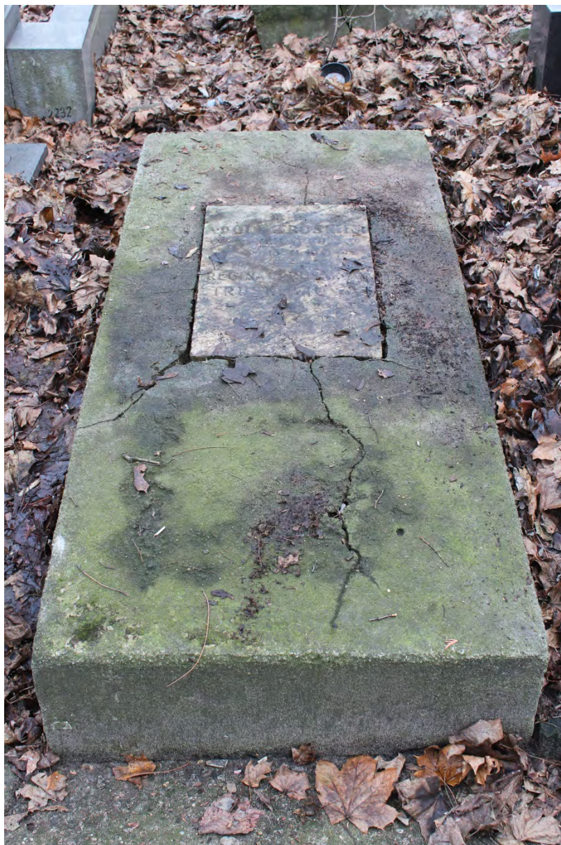
Foto. 1 Nagrobek Adolfa Truskiera [sektor 10, rząd 3f, nr 18]. Widok ogólny pokrytej biologiczno-chemicznymi nawarstwieniami betonowej płyty. Widoczne liczne, głębokie i ubytki. Fot. D. Pisarski. 2017.
