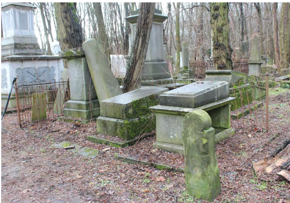
Fot. widok ogólny.
