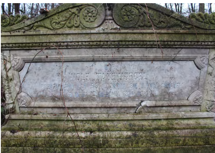
Fot. Ubytki liternictwa na powierzchni płyty inskrypcyjnej.
