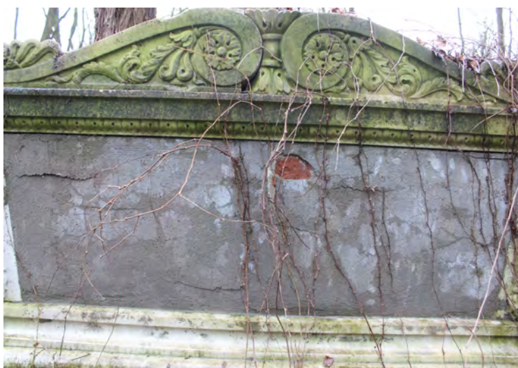
Fot. Wtórnie murowana i tynkowana brakująca tylna ścianka sarkofagu.
